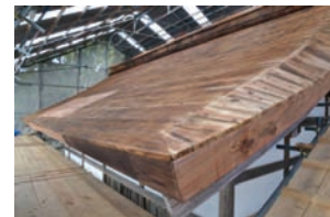
屋根下地の修理状況
