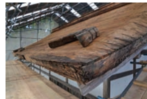
銅板屋根解体時の屋根下地破損状況
