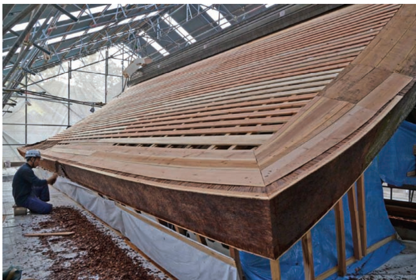
神門での修理状況
