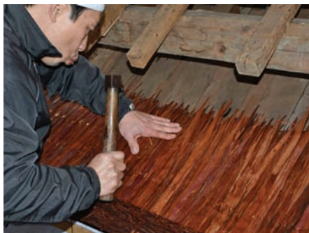
檜皮葺き作業の様子
