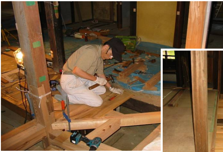
中庭廻りの縁の張り立て
