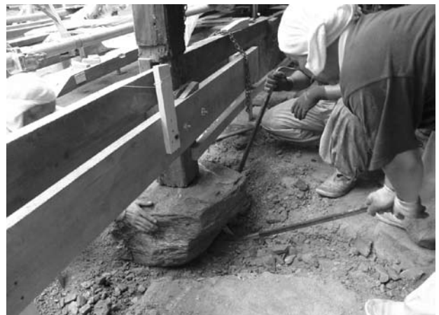
求聞持堂礎石の据替
