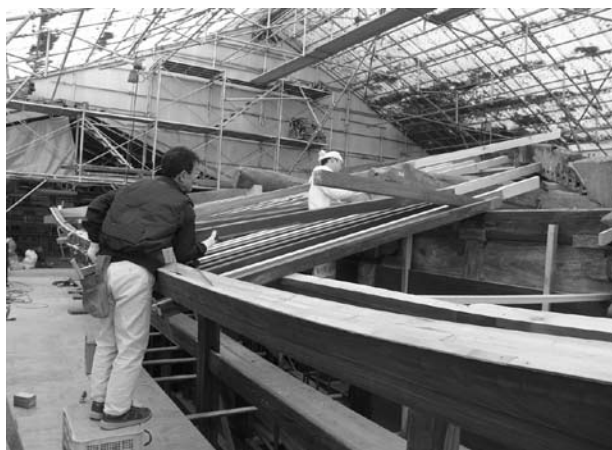
本堂化粧垂木の組立状況
