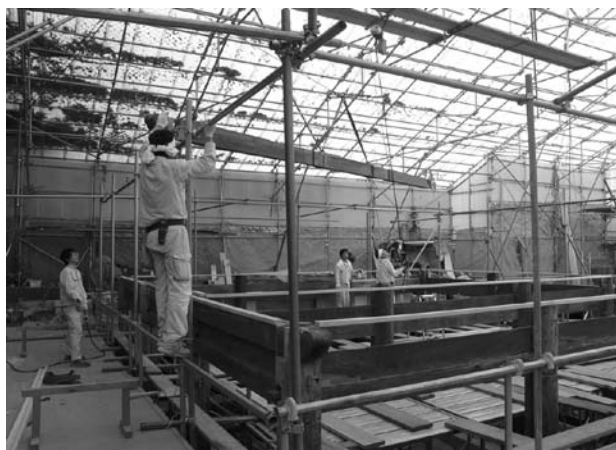
本堂頭貫の組立状況
