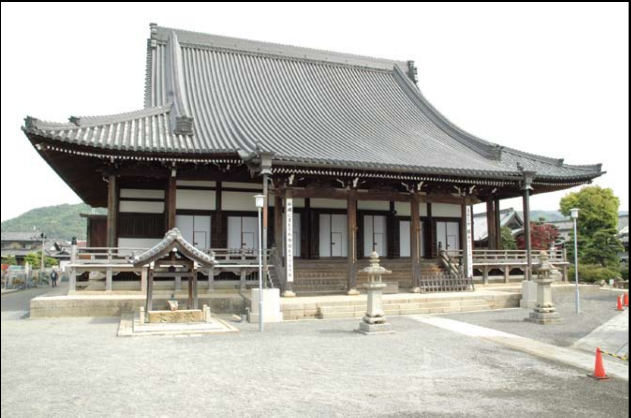
7. 修理が竣工した総持寺本堂
