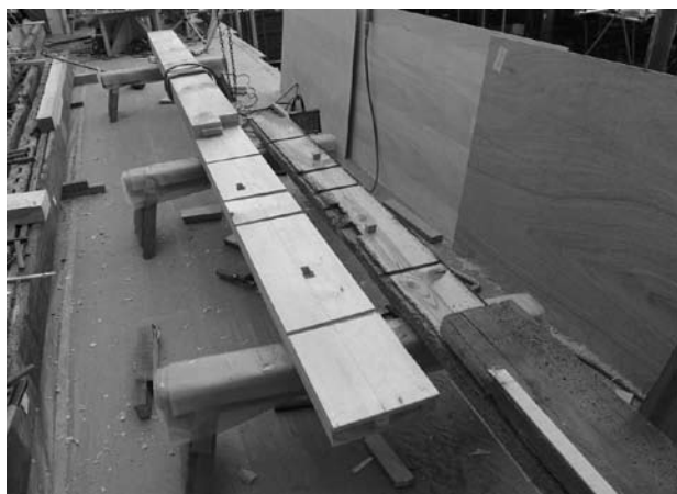
本堂の貫の修理状況
