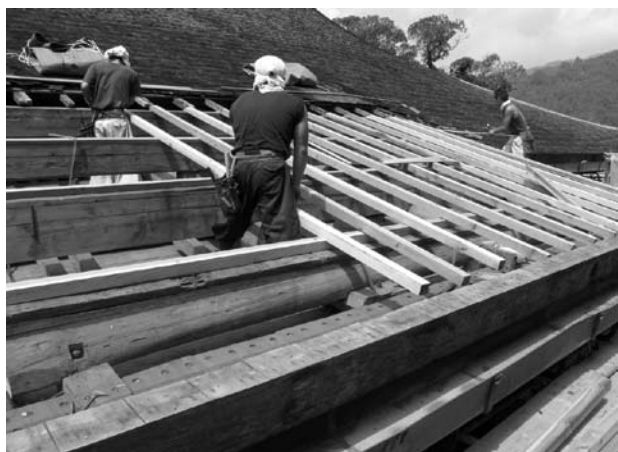
向拝の野垂木修理
