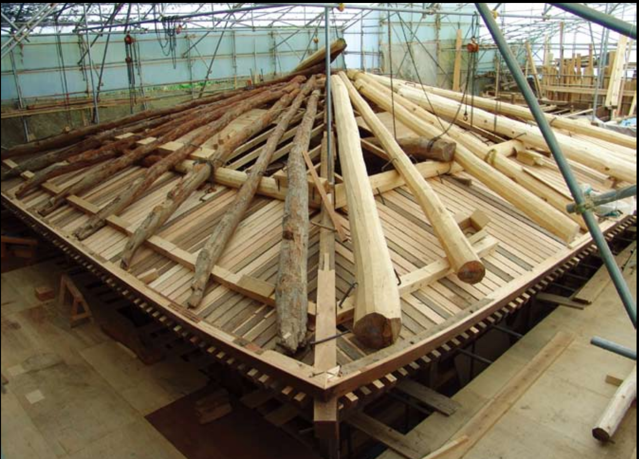
8. 組立て中の福勝寺本堂
