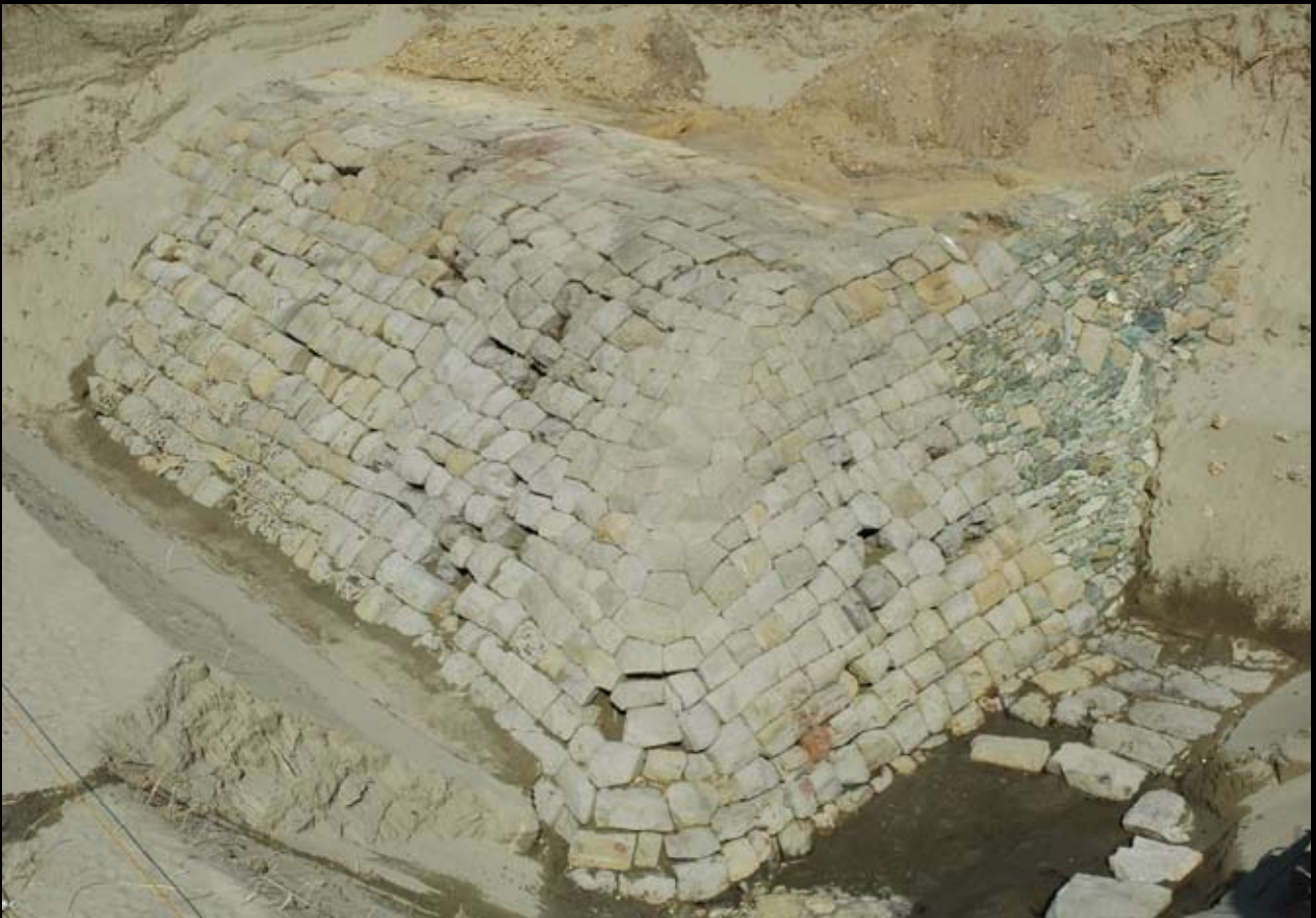
1. 水軒堤防の石堤 南西から（和歌山県教育委員会より提供）
