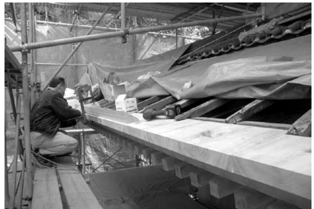
多宝塔下層屋根の裏甲等の修理
