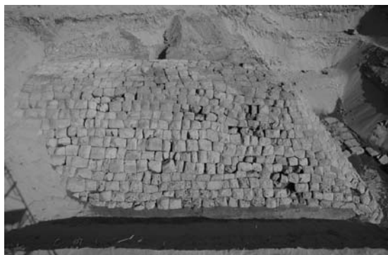
石堤西側面（西から）
