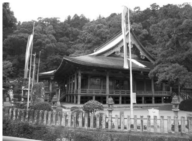
正面及び側面の一部竣工
