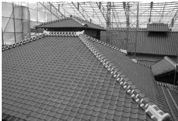
主屋根葺き工事完了状況
