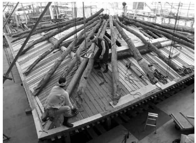
当初小屋材の組み立て状況
