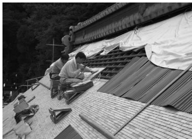
こけら板の葺き上げ状況
