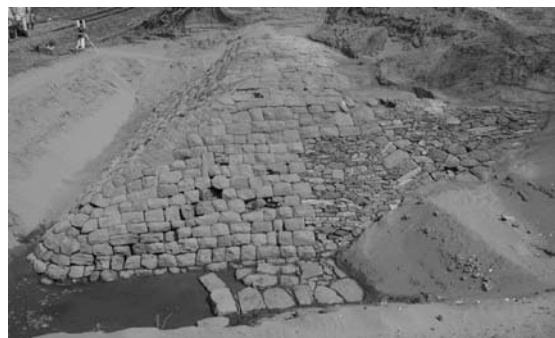
石堤南側面（南から）
