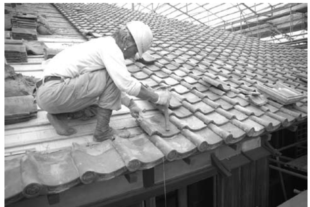
主屋棧瓦葺き作業
