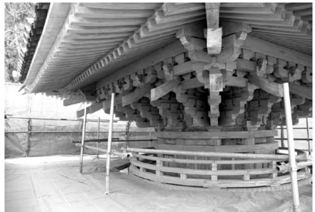
多宝塔は古塗装ケレンが完了
