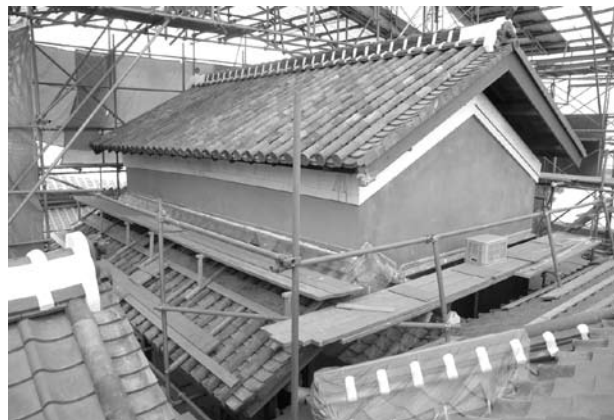
内蔵は下屋庇を葺き、壁は中塗りまで完了
