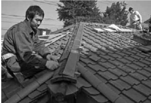
茶室の屋根葺き状況
