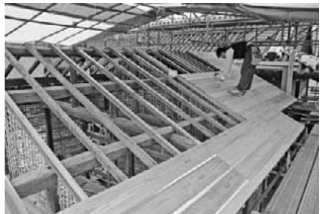
人力車庫の野地板打ちの状況
