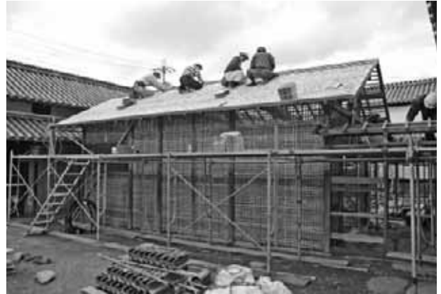
味噌部屋の土居葺きの状況
