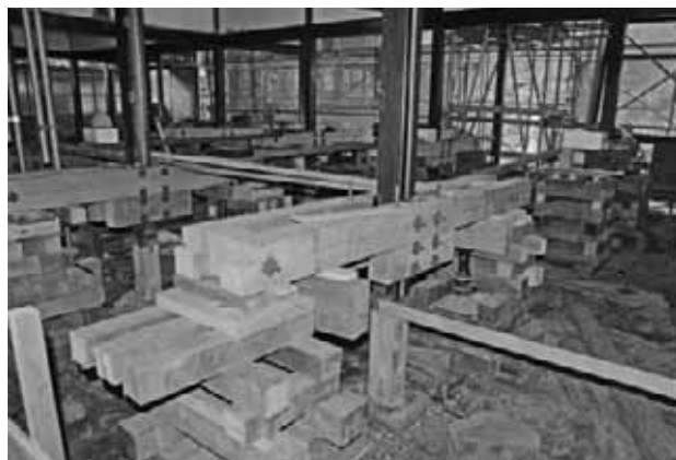
軸組みの修理状況
