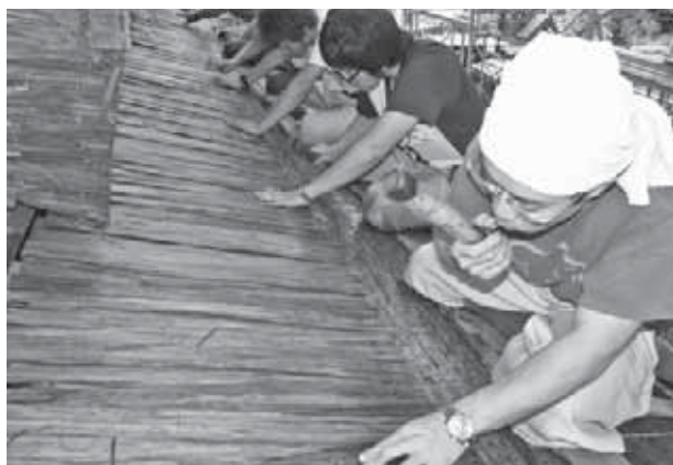
本殿西面屋根 檜皮平葺き施工の様子
