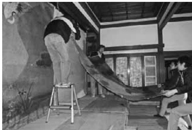
大床障壁画の解体状況
