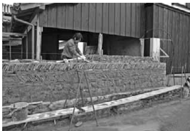
北西土塀の本体積みの状況
