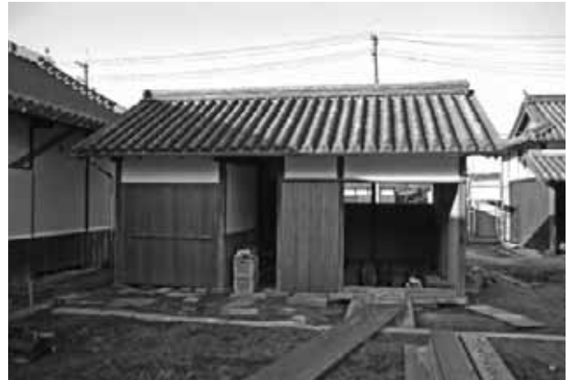
竣工 人力車庫外部
