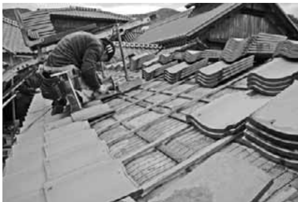
便所 屋根葺き状況
