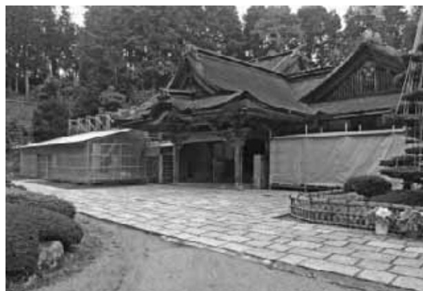
客殿、台所前の仮設通路兼軒足場
