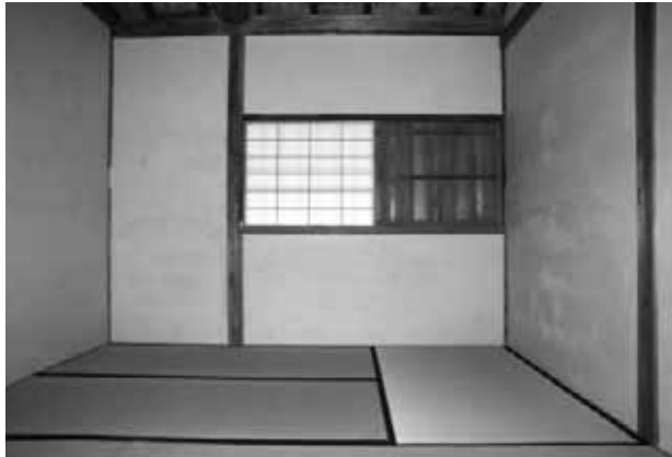
竣工 味噌部屋内部（西側部屋）
