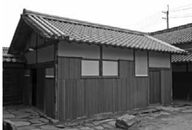
竣工 味噌部屋外部
