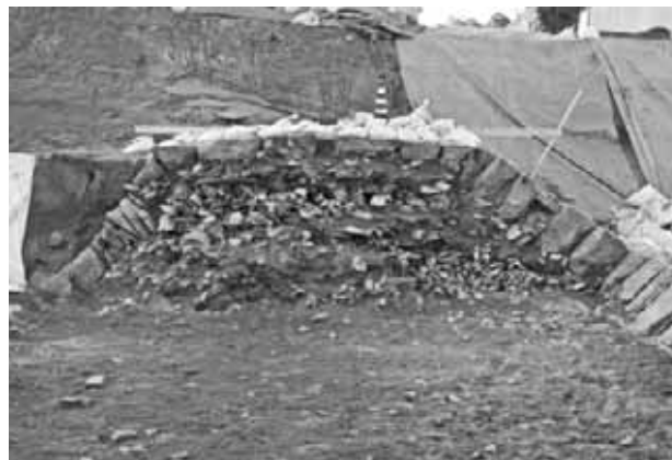
石堤断面 北から
