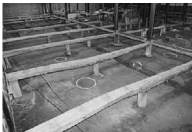
客殿大広間解体完了並びに発掘状況
