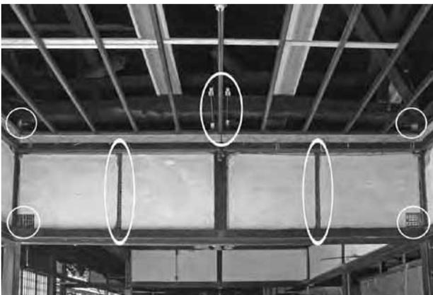
寺務所西面の補強金具取り付け状況(丸線内に補強金具)
