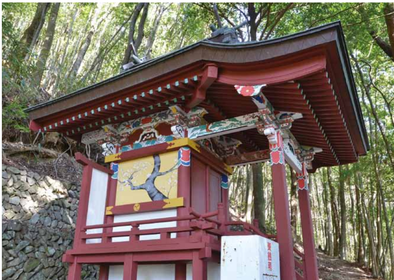
8 継桜王子跡社殿(竣工)
