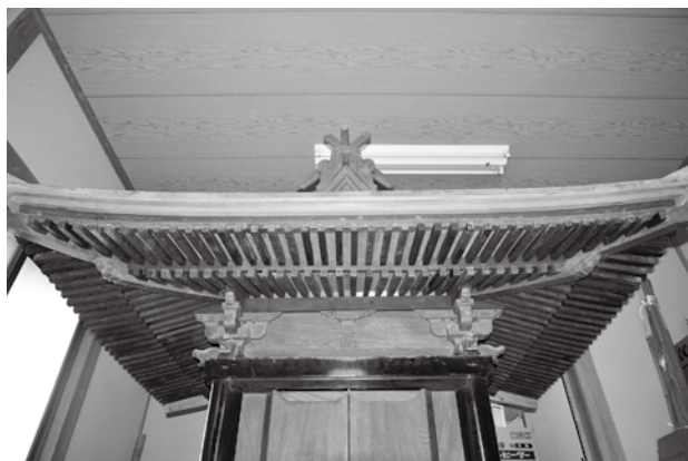
宮殿軒廻りの修理完了状況
