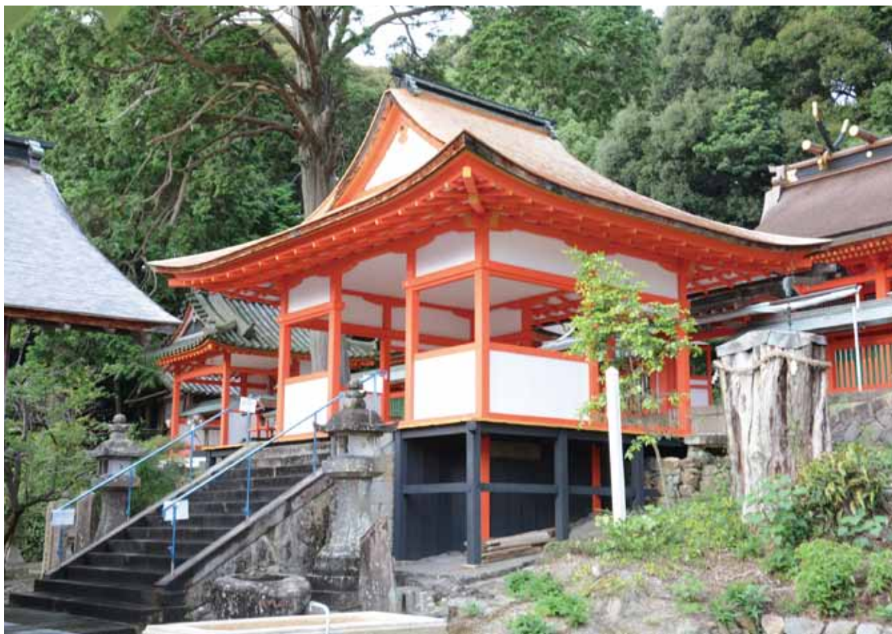
3 広八幡神社拝殿(竣工)
