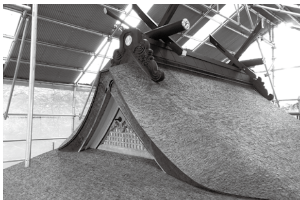
屋根工事完了
