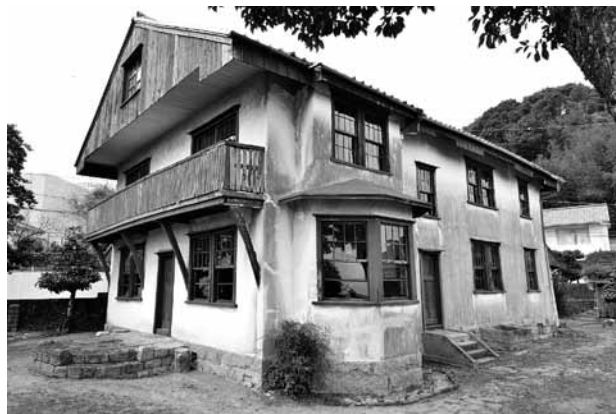
主屋を南東からみる（修理前）
