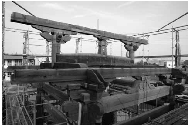
軸部組立状況
