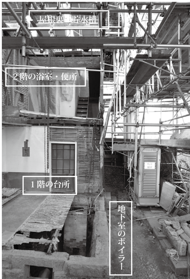
写真3 建物北東に集められた設備類（地下水を貯水槽へ汲み上げ、地下室のボイラーへ下ろして温め、浴室などへ給湯しました）
