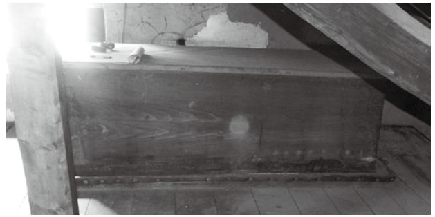
写真4 屋根裏に置かれた貯水槽
