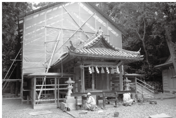
拝殿の礎石取り替えに伴う揚屋工事
