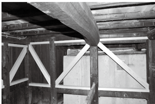
拝殿床下の補強材設置状況
