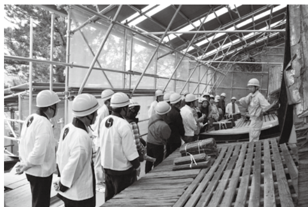
宝来山神社での修理現場見学会の状況
