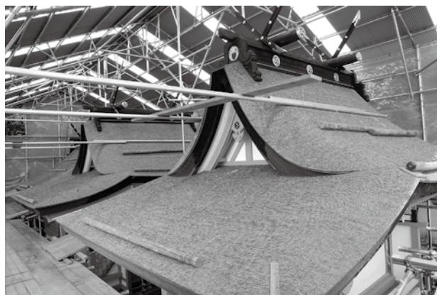
檜皮工事状況（第二殿から西殿を見通した写真）
