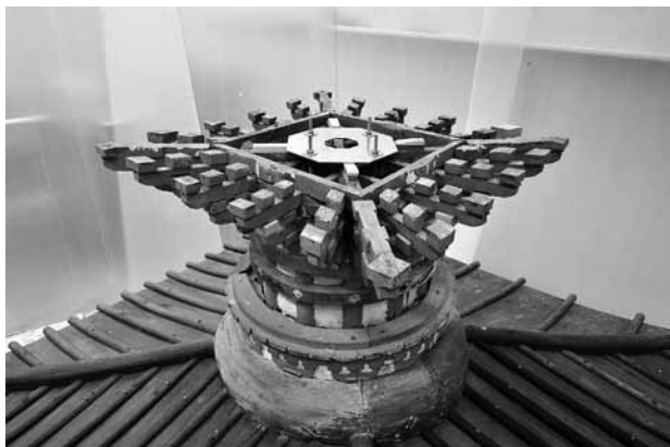
二重組物組立状況
