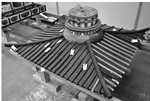
一重瓦棒補足材仮組状況
