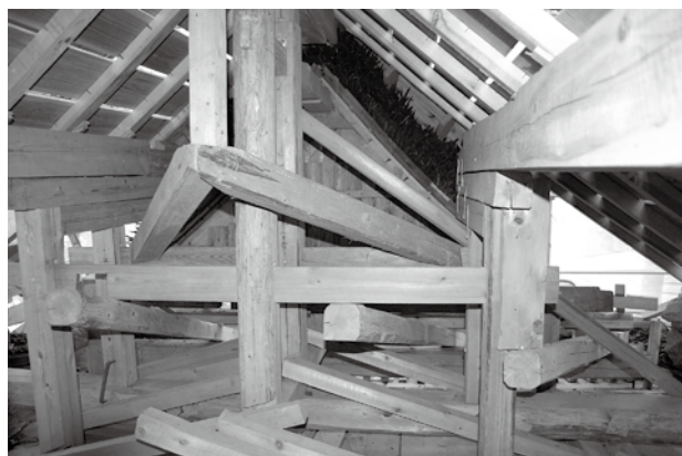
昭和32年に修復された小屋組
