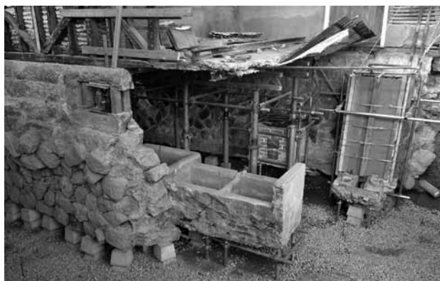
地下室北東の基礎工事状況
