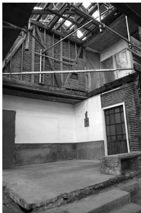
主屋北東部分の分解状況
