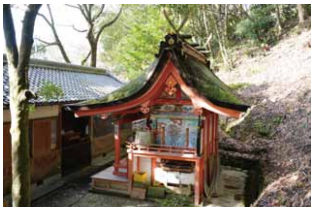
修理前の上岩出神社本殿
