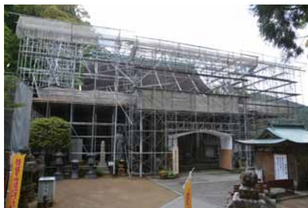
素屋根建設中の様子を東南より見る
