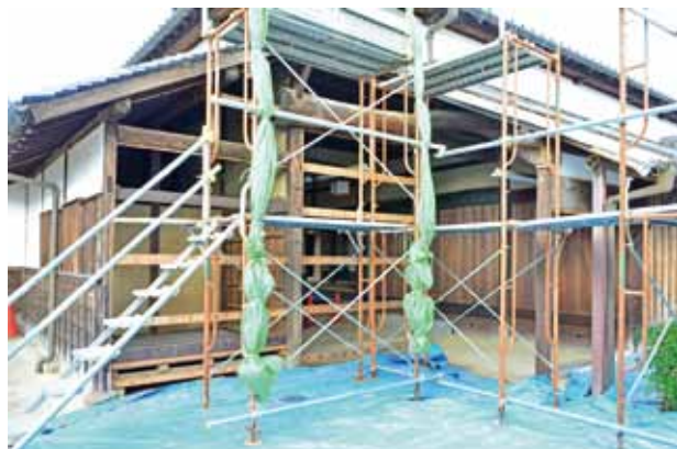
現状変更に関わる主屋南西隅部分
