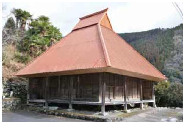
修理前の地蔵堂全景
