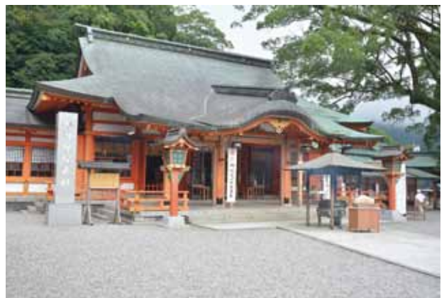
修理前の熊野那智大社拝殿
