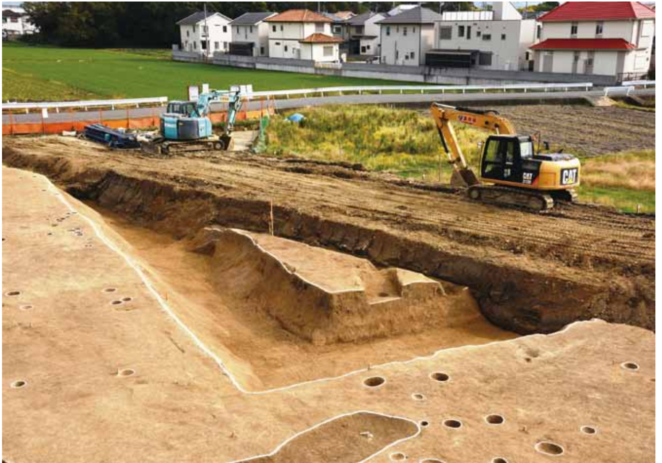
1 東城跡発掘調査 堀コーナー部(北西から)
