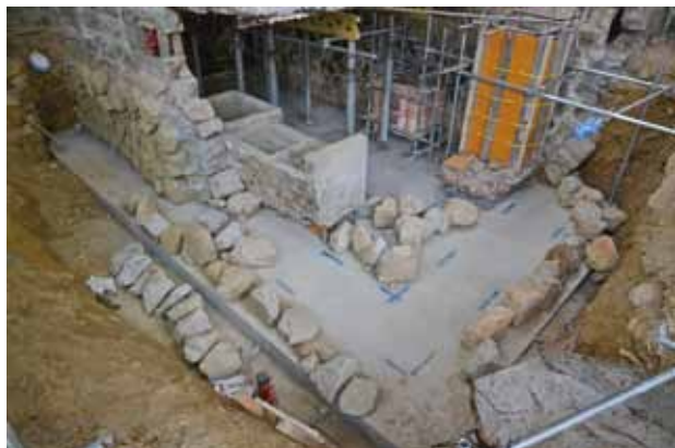
主屋北東、地下室部分での基礎工事の様子
