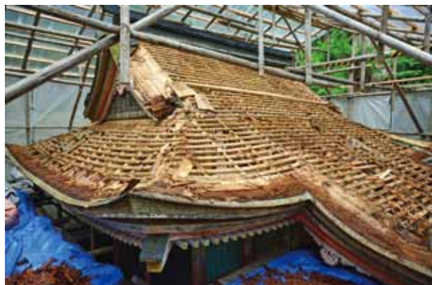
旧檜皮解体後の状況
