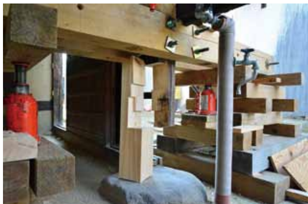
流し廻りの腐朽した柱の根接ぎ
