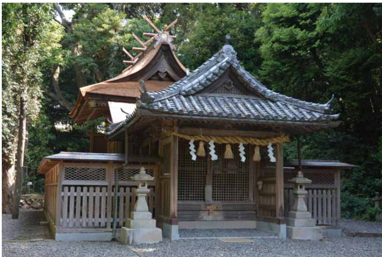
2 切部王子跡社殿(切目神社本殿) 竣工
