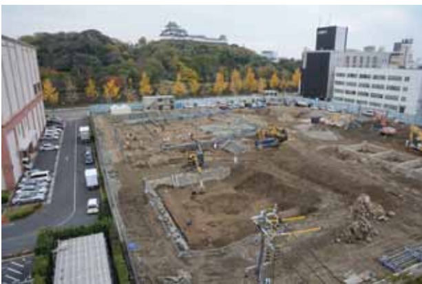
調査地(北東から)
