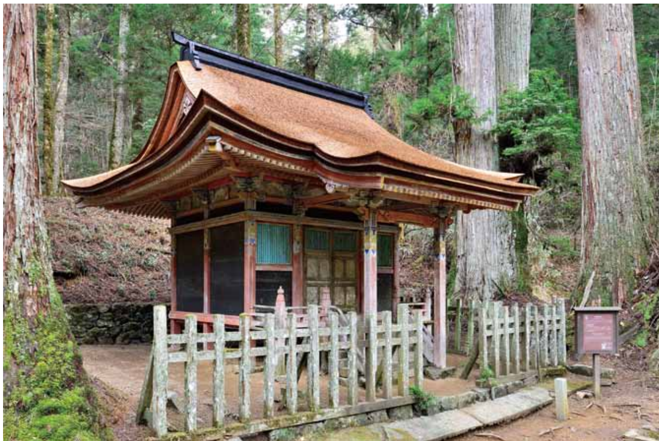
1 上杉謙信霊屋 竣工
