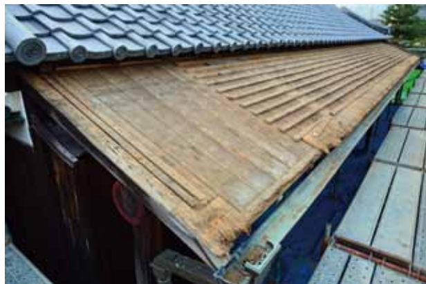
こけら葺き土庇の解体状況
