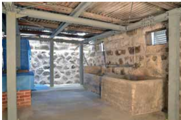
地下室内部、鉄骨フレームの設置状況
