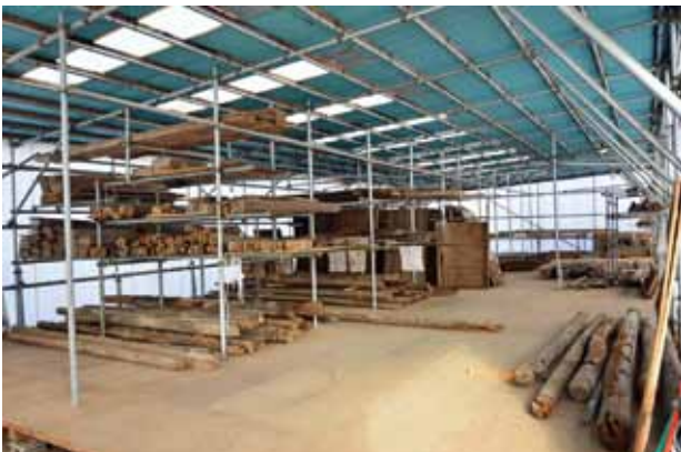
部材倉庫内(整理完了)
