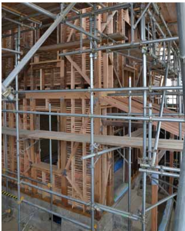
主屋北東での軸組復旧の様子
