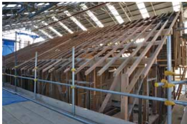
主屋北東での軸組・小屋組復旧の様子
