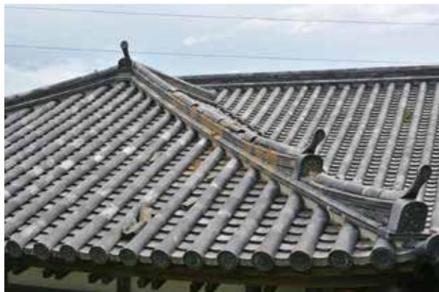
浜座敷北面での棟積み破損状況（修理前）
