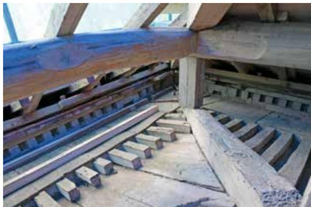
東面軒裏での補強材挿入状況
