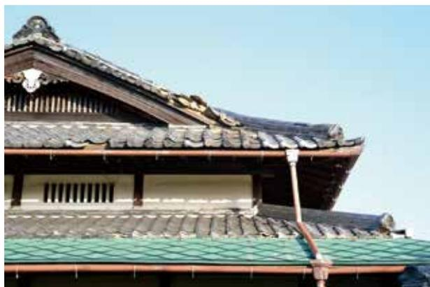
主屋南面での軒瓦・掛瓦の破損状況（修理前）
