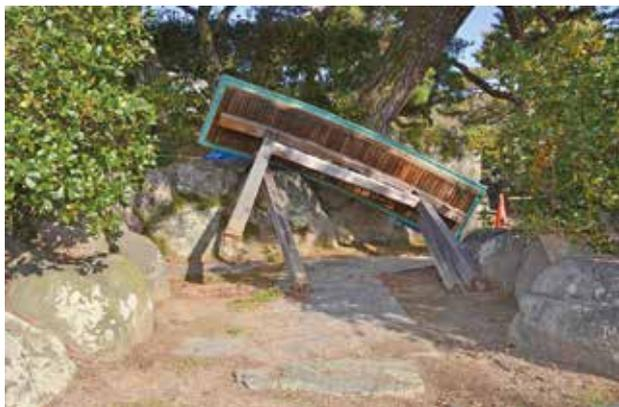
南冠木門での柱折損・転倒状況（修理前）
