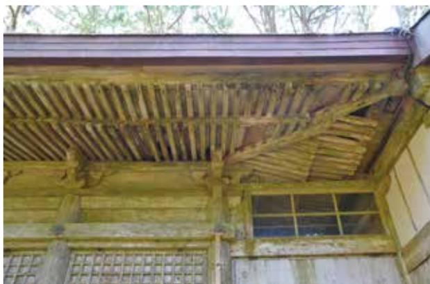
修理前の東面軒（雨漏りによる部材の腐朽・欠損）
