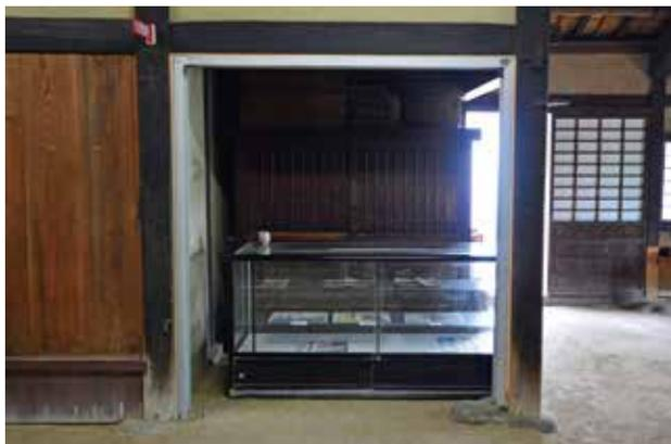
耐震補強（鉄骨フレーム）組立途中
