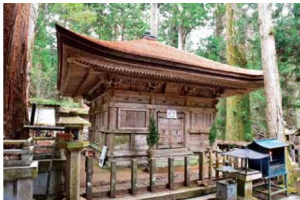
屋根工事の完成
