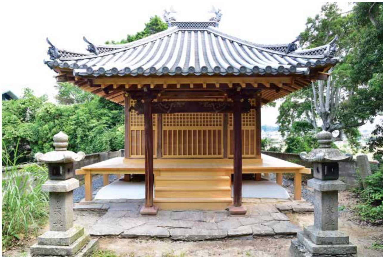
3 藤崎弁天堂竣工正面
