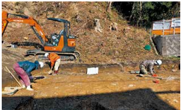
人力掘削作業
