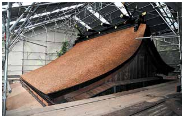
屋根工事完了状況（東からみる）
