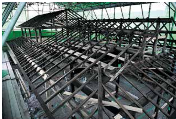
木部組立状況
