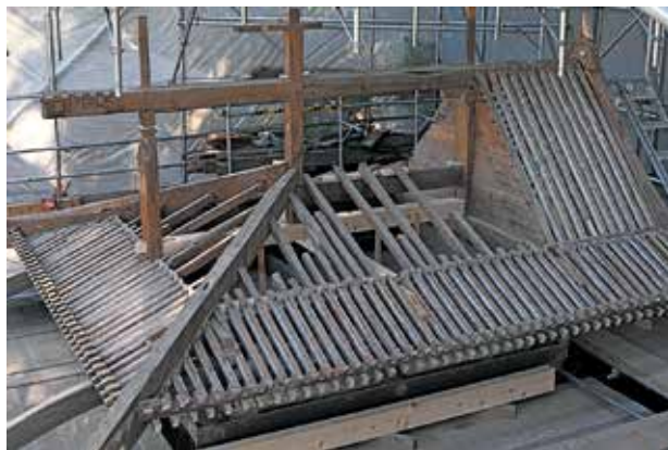
軒・小屋組復旧中の本殿（小屋梁・地棟を新調）
