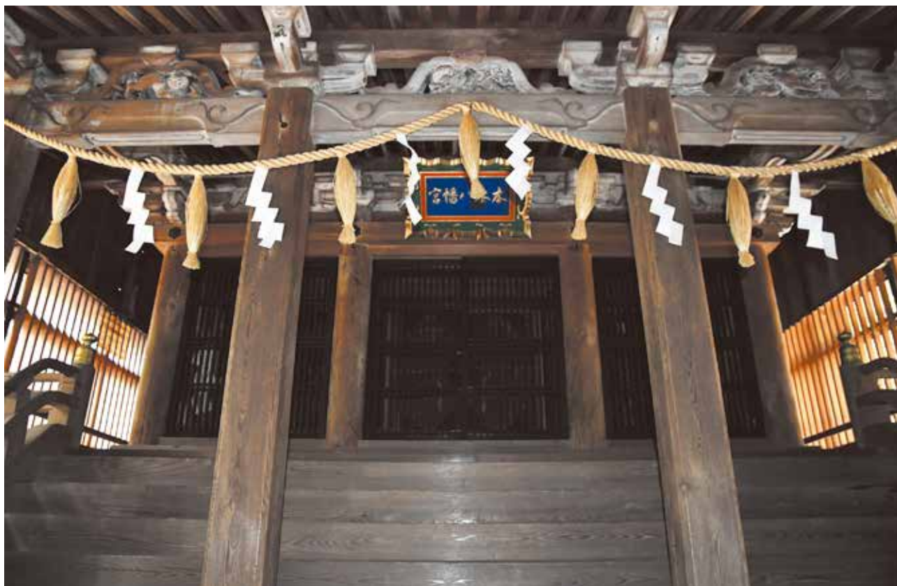
4 木ノ本八幡神社本殿竣工正面
