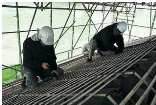
屋根下地小舞掻き状況
