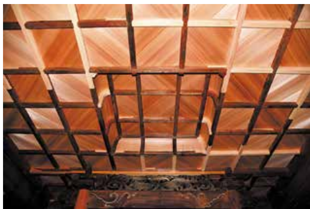
復原した天井 天井板が斜め張られている
