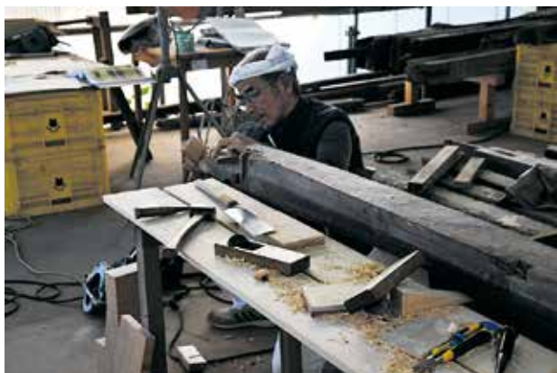
再用材補修状況
