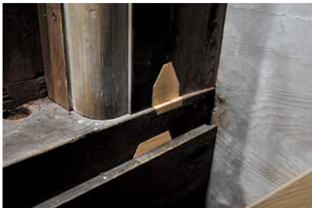
木部破損の修理状況（内外陣境）
