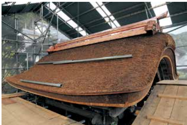
檜皮葺き直し後の表門屋根（南東から見る）
