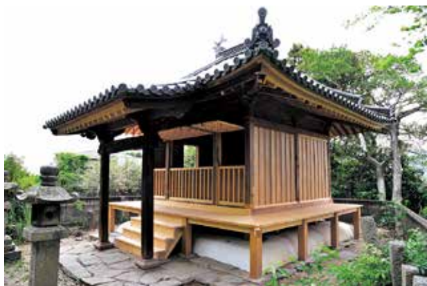
蔀戸を開けた正側面全景
