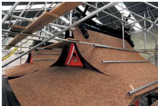
檜皮屋根・箱棟修理後の第一殿（手前）と第二殿
