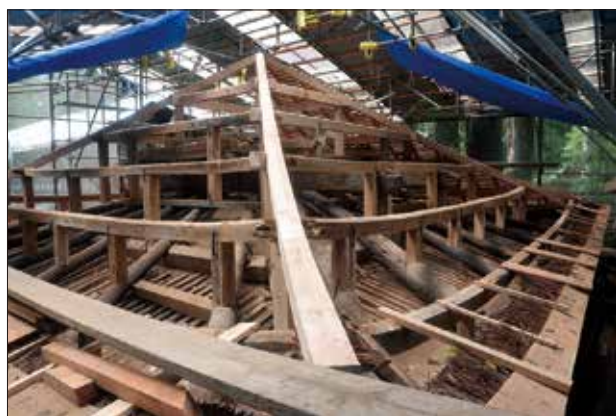
小屋組の修理状況
