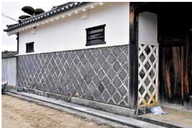
ナマコ壁の漆喰の解体状況
