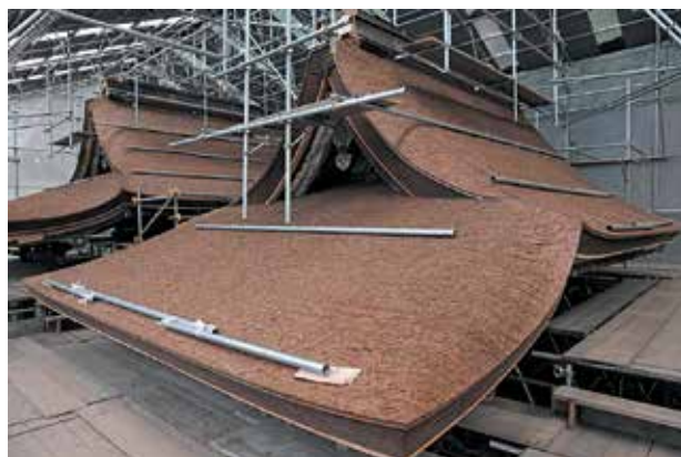
檜皮屋根葺き直し後の本殿と上殿（手前）
