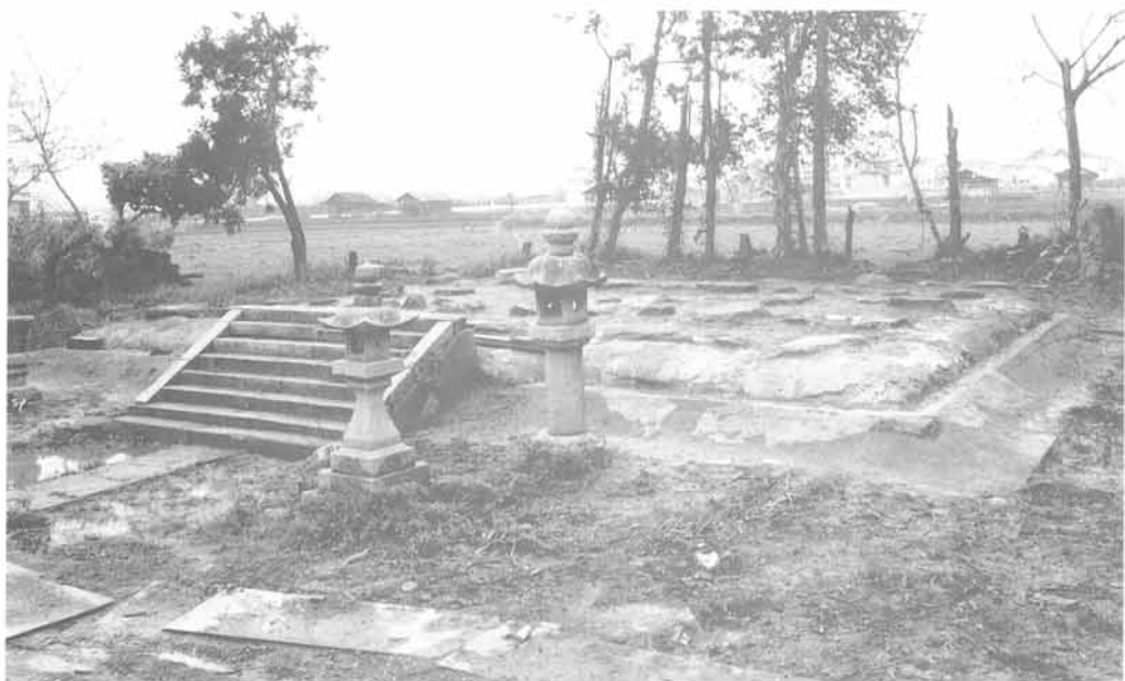
国分寺本堂 解体完了後(南東から)
