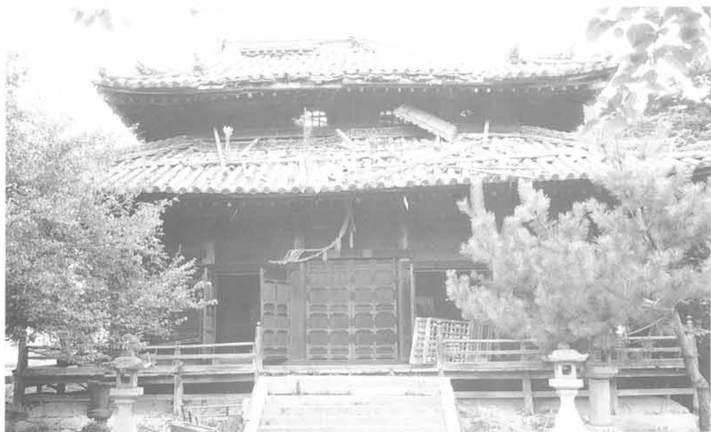
国分寺本堂修理前 正面(南から)
