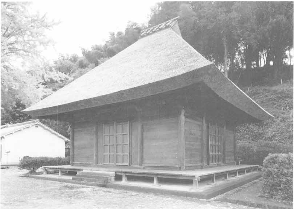
法音寺本堂(南東から)
