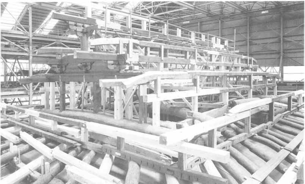
道成寺本堂小屋組組立中(南西から)
