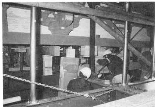
二階柱の解体(斗拱からは持ち上げ、仮に支えている)
