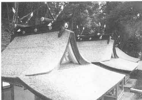
本殿屋根葺替完了の状況
