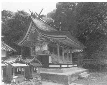
竣工（北西より見る）
