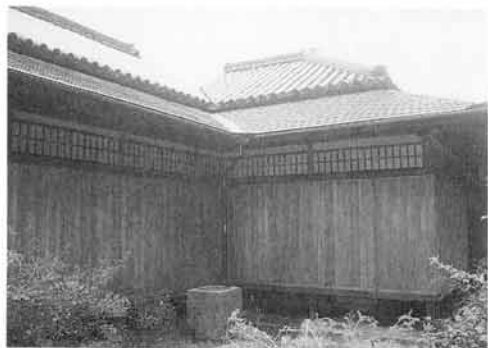
長保寺客殿竣工
