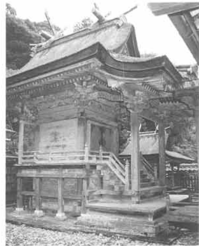
日神社本殿 修理前
