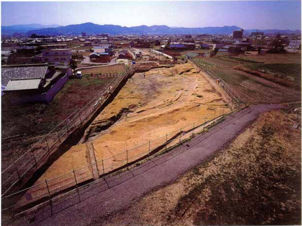
1. 根来寺坊院跡 調査地全景（北々東より）
