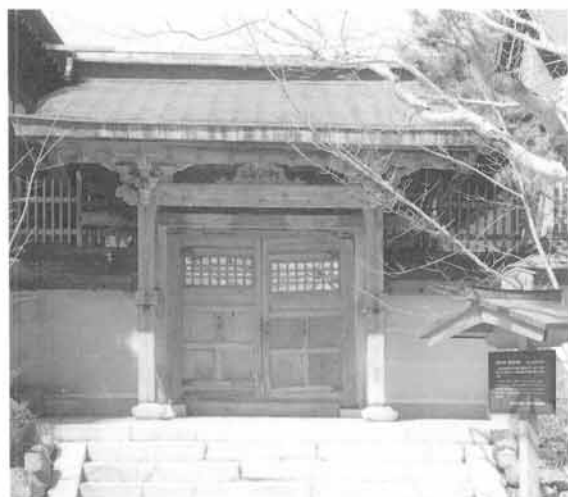
普賢院四脚門正面全景
