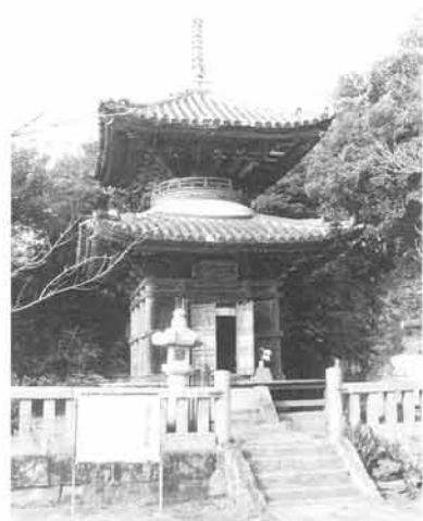
海禅院多宝塔 修理前
