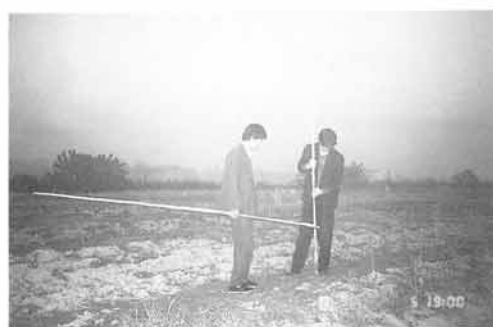
洛陽鑽によるボーリング風景
