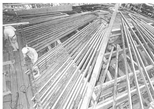
扇垂木組立の状況
