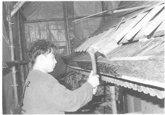
軒付の作業中
