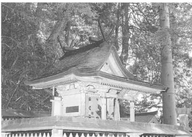
金剛三昧院四所明神社本殿正側面全景
