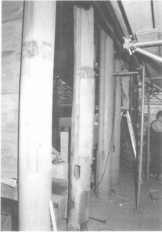
下層柱の取替修理
