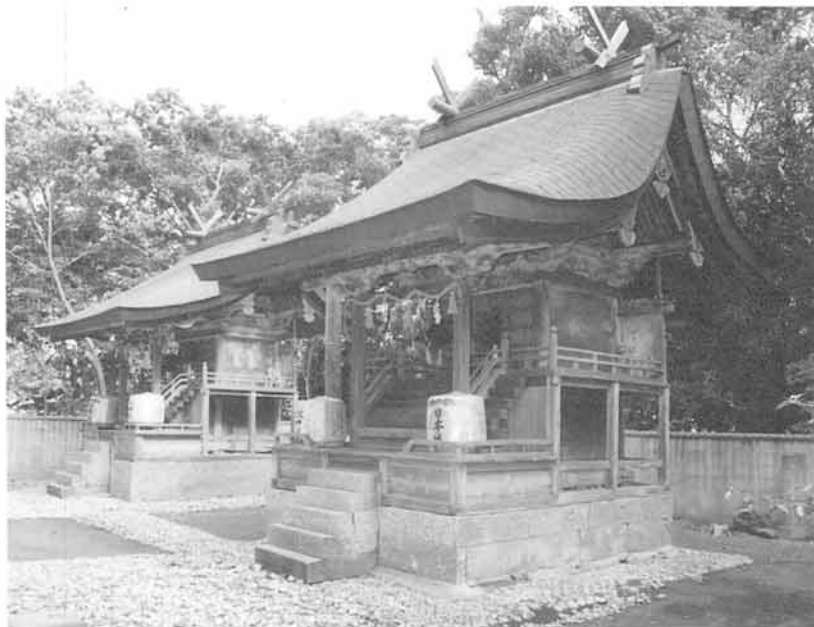
力侍神社 修理前
