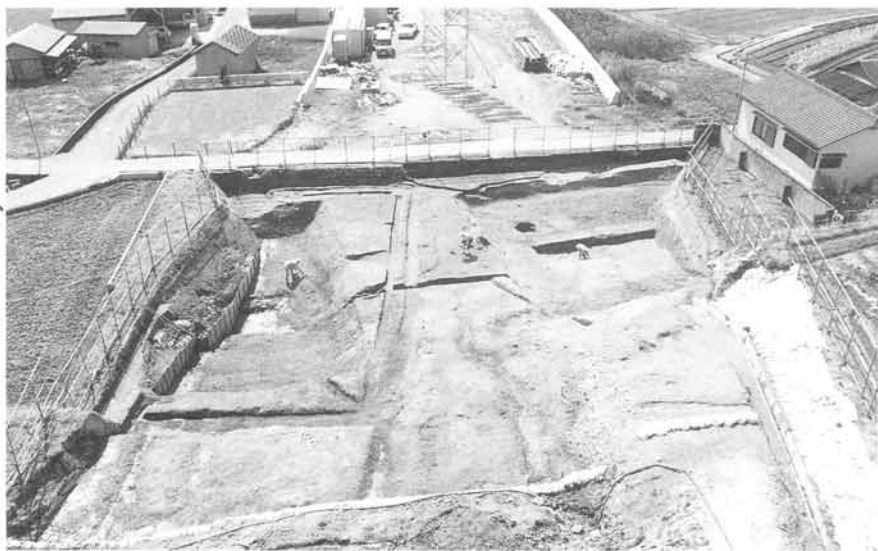
南側調査地 土橋と堀
