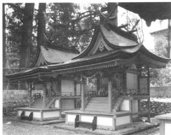
摂社本殿の正側面全景
