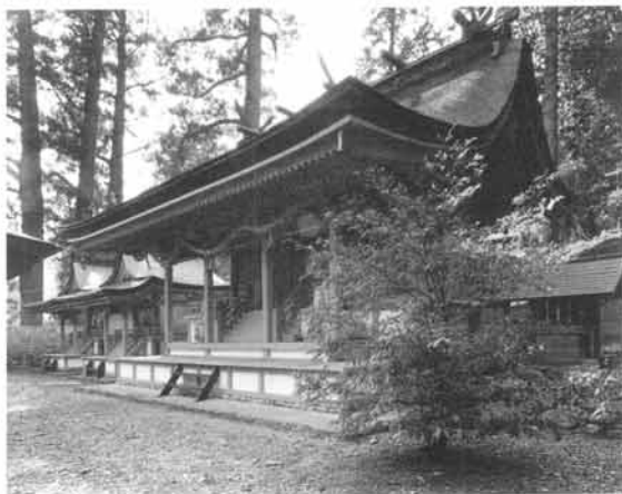
本殿の正側面全景
