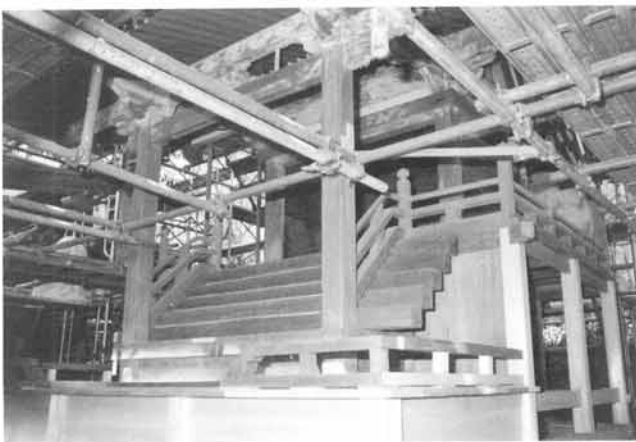
組立中の八王子神社社殿
