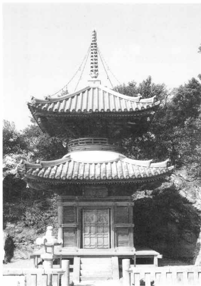
海禪院多宝塔全景
