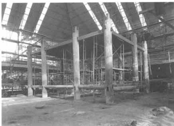
解体中—身舎柱を残した状況
