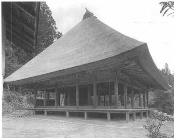
竣工－正側面の全景
