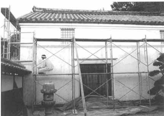
漆喰壁の塗り替え：旧柳川家住宅前蔵
