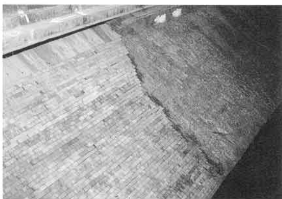
旧屋根面を生かした檜皮の葺き替え：瑞垣
