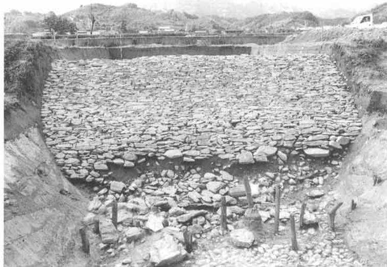
石堤の表法面(南から)
