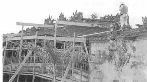
調査のため足場の架けられた「日本橋」
