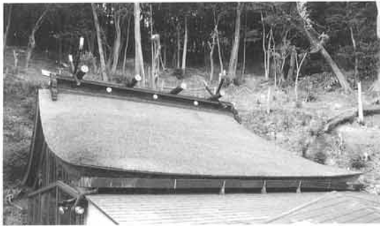
檜皮葺屋根：竣工
