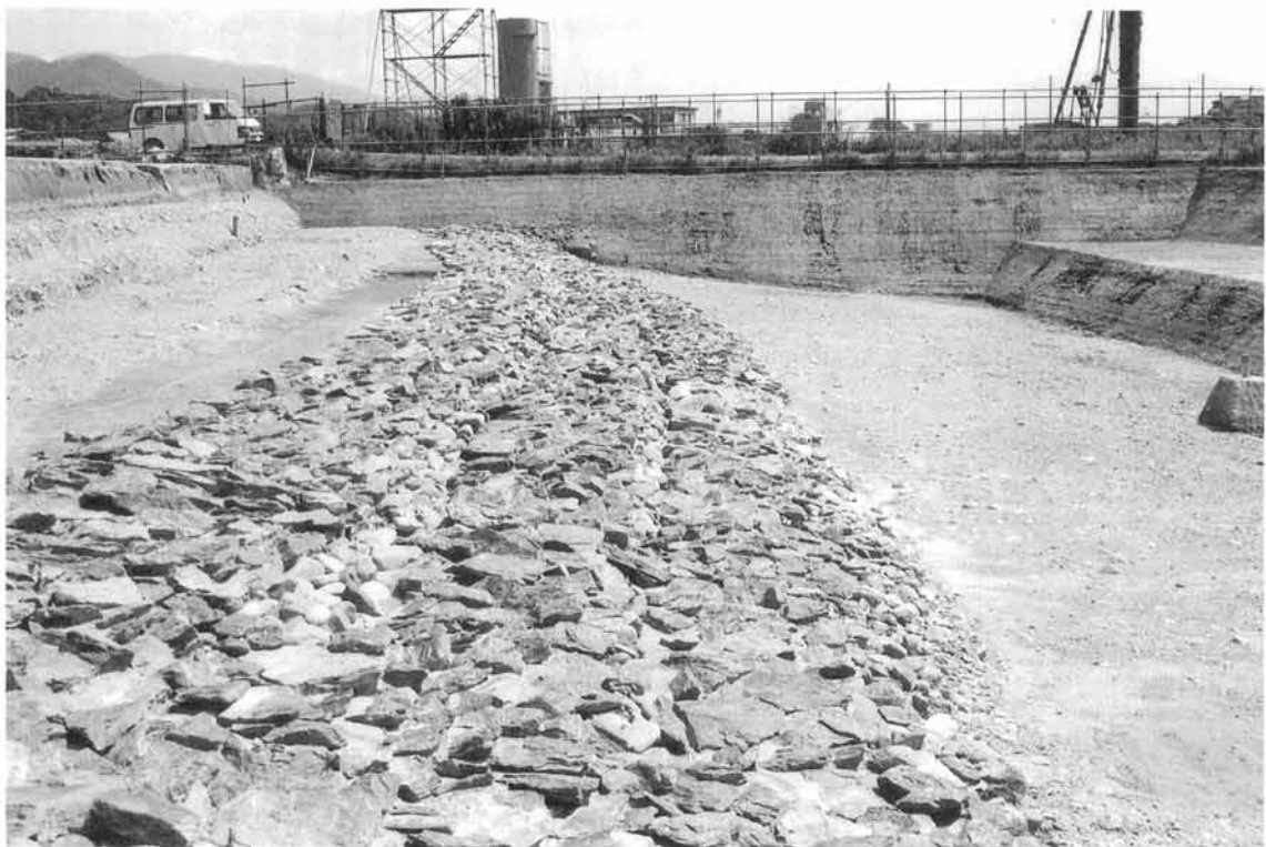
石積みの護岸
