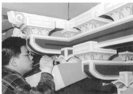
彩色工事の状況：楼門
