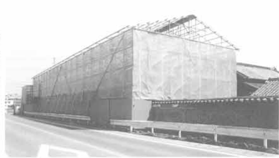
4. 長屋蔵 素屋根建設完了
