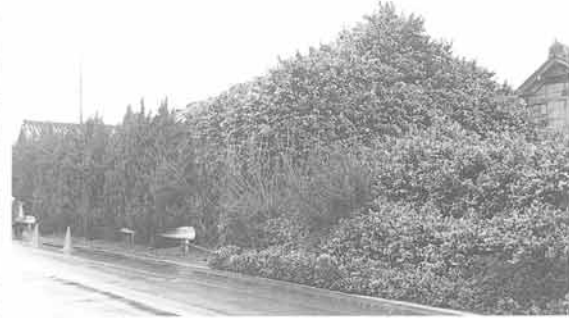
2. 長屋蔵 修理前の状況
