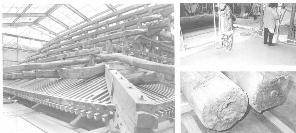
(左) 解体状況 (右上) 土間叩き (右下) 一階柱底部の腐朽状態
