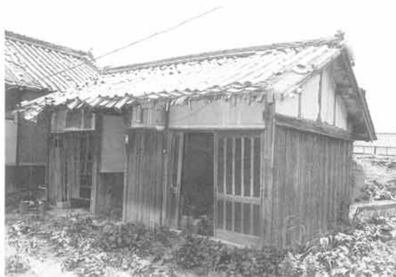
解体前の人力車庫
