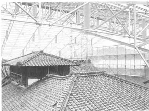
トラス組立て状況
