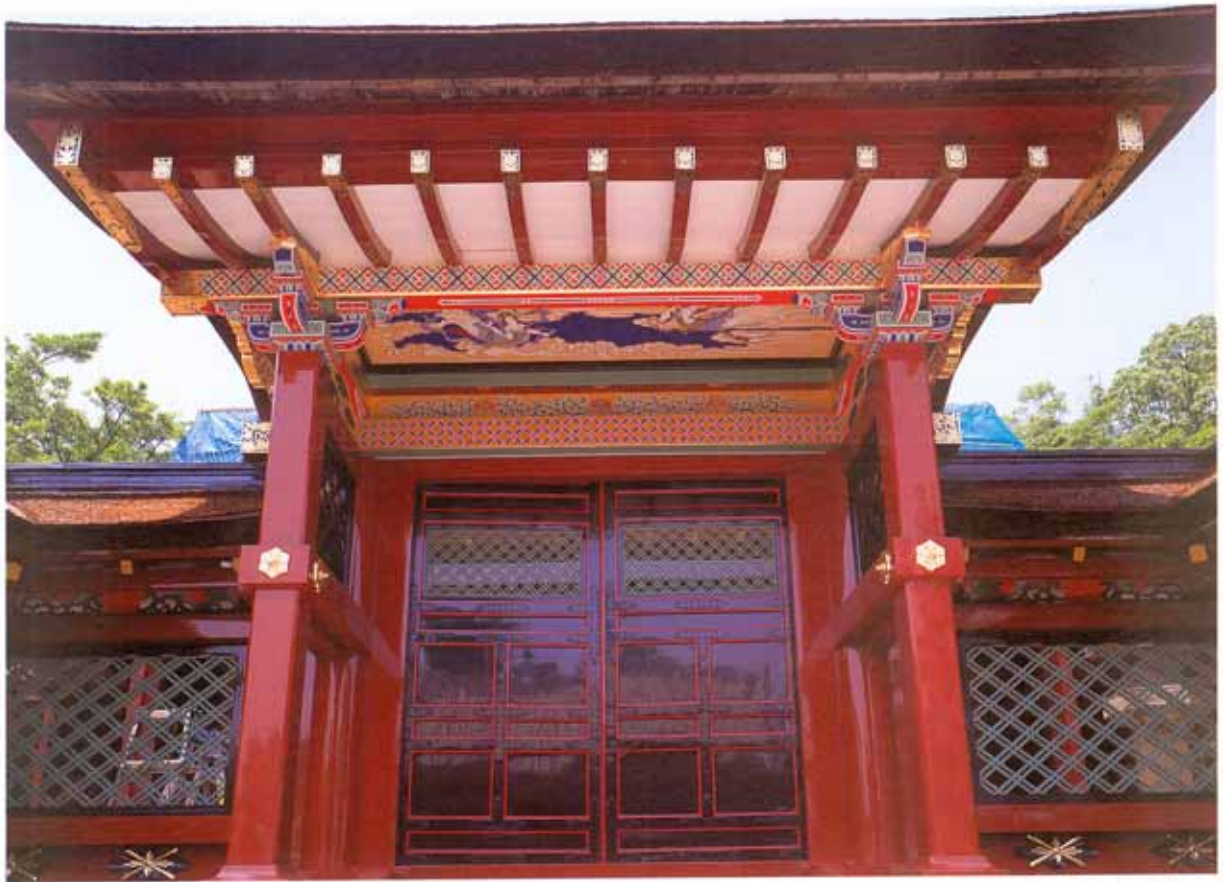
3. 東照宮唐門（竣工）
