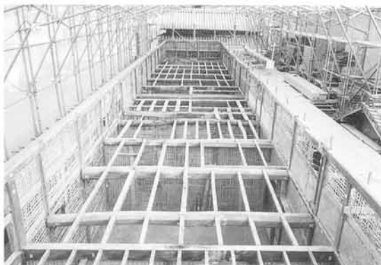
長屋蔵解体の状況（南から見通す）
