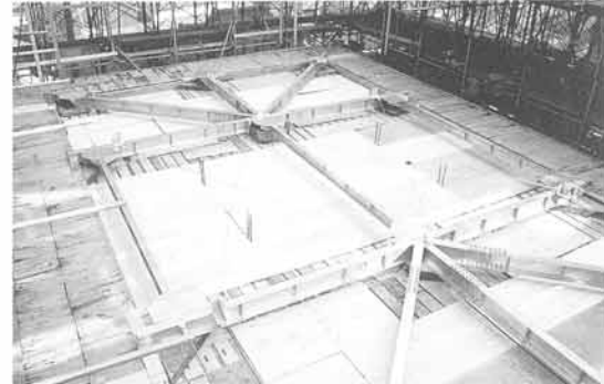
2. 1ー2階間の鉄骨梁補強
