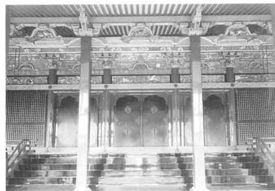
竣工 拝殿向拝正面
