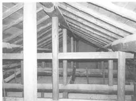
左：帯鋸挽きの小屋組 昭和10年建築 右：帯鋸機械 かつらぎ町内にて
