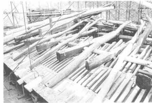
4. 軒廻り、小屋組の組立て
