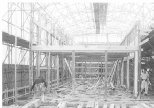
写真3 長屋蔵の解体状況
