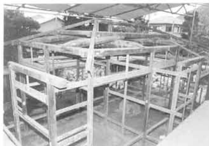
写真2 茶室の解体状況
