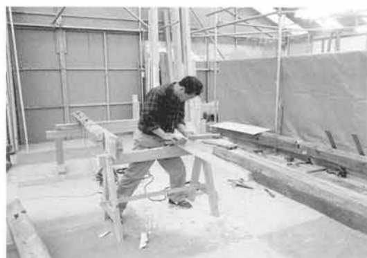
写真4 長屋蔵部材のつくろい
