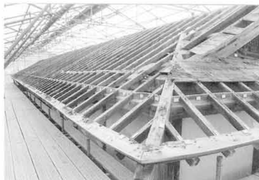
写真2 表門屋根の解体状況
