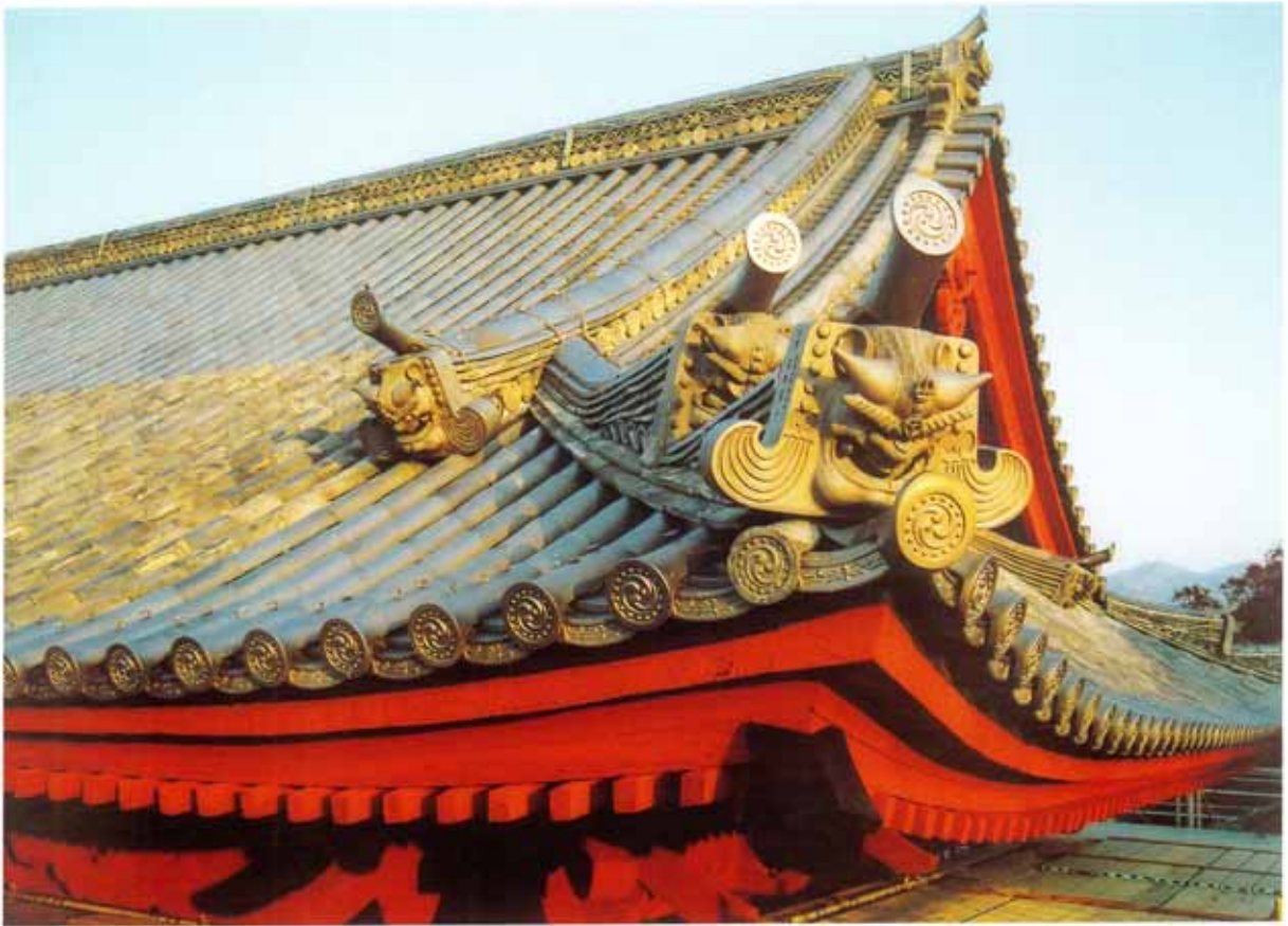
3. 粉河寺大門 屋根本瓦葺き
