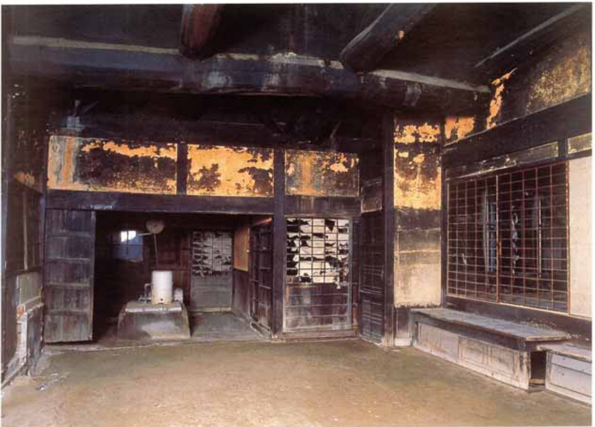
4. 旧中筋家住宅主屋 修理前の土間空間
