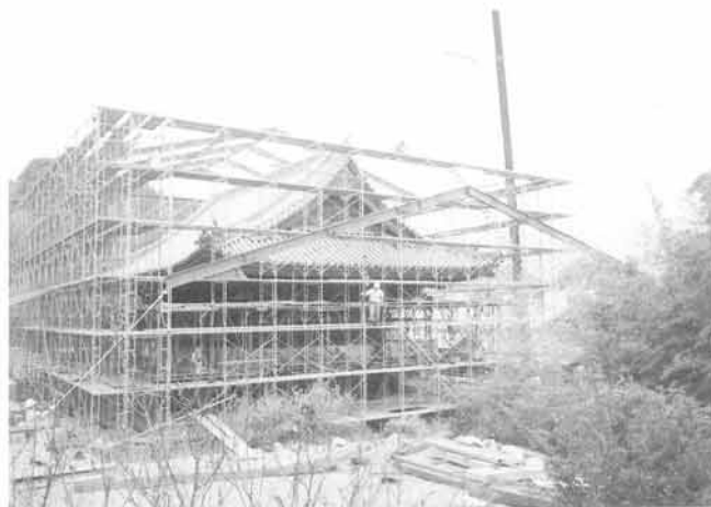
4. 仮設解体工事
