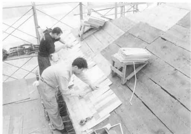
2. 土居葺き工事
