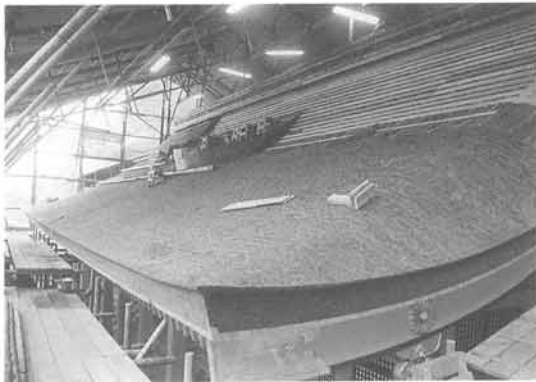
屋根工事施工の状況
