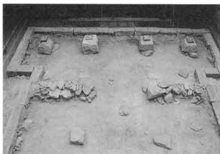
基礎 足元廻りの解体の状況 後方より前方を見る
