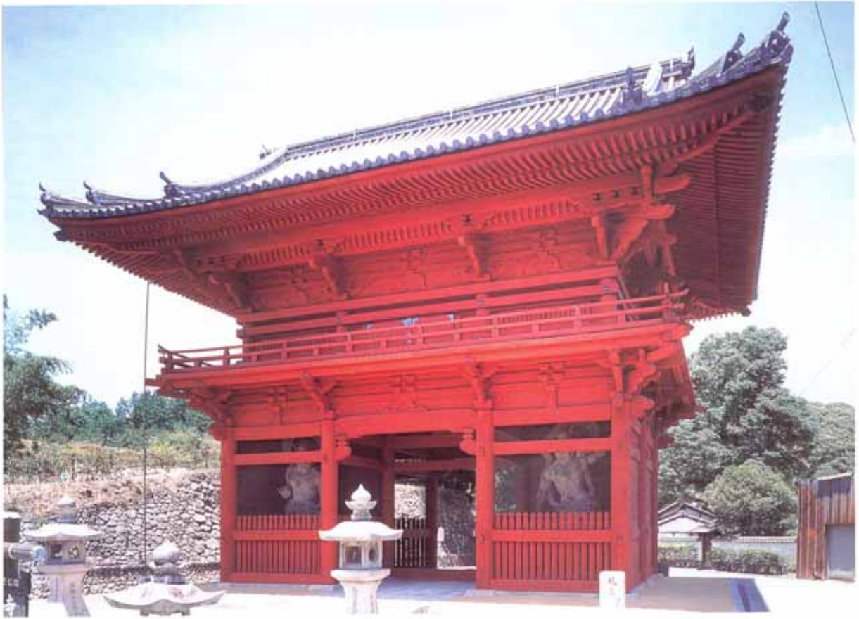
3. 粉河寺大門 竣工全景
