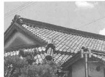
旧中筋家住宅の隣家も丸棧で葺く
