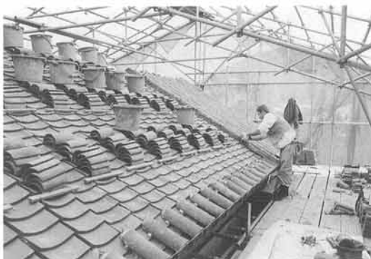
北蔵の屋根葺き工事
