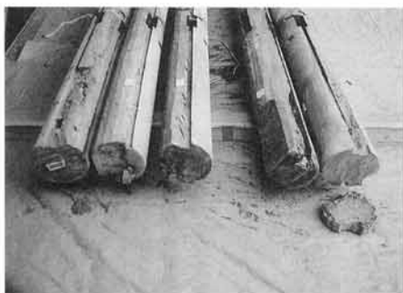
柱下端部の切断 右端は切片が残る
