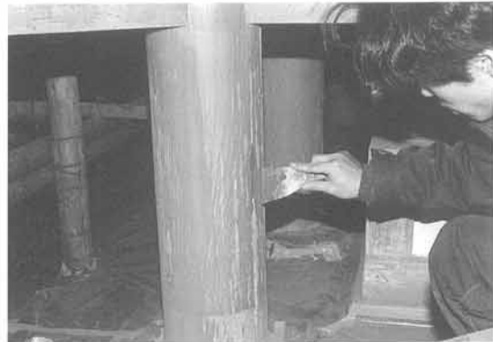
塗装工事施工の状況
