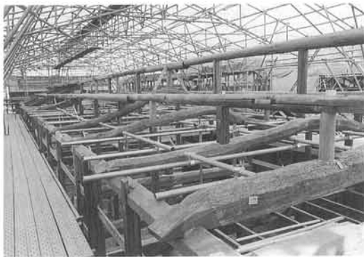
長屋蔵の軸組・小屋組の組立完了
