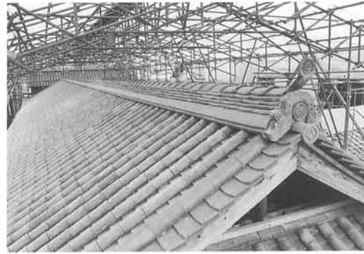
長屋蔵の屋根葺き完了
