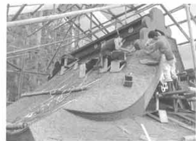
高野明神社の屋根葺状況
