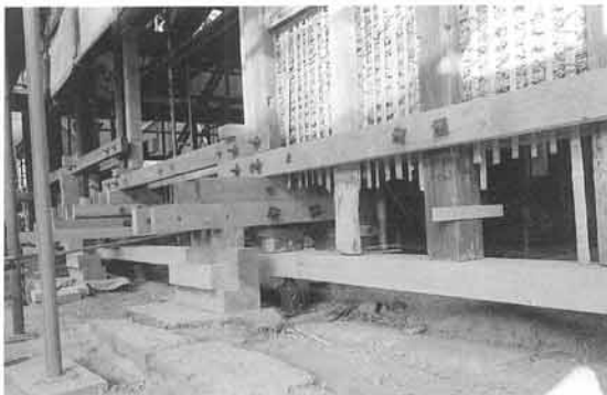
主屋の不陸調整作業
