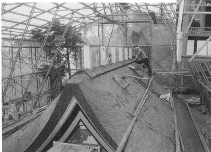
屋根桧皮葺きの施工
