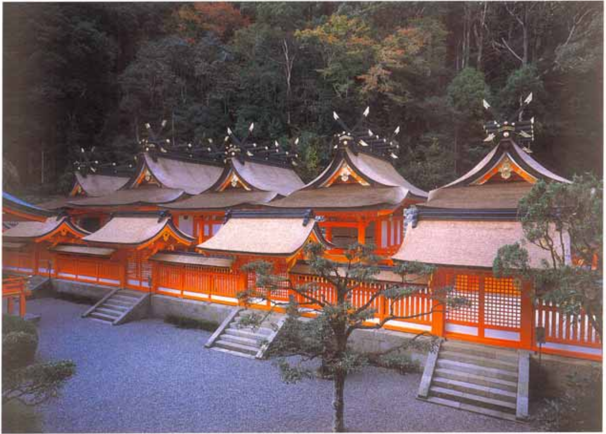
3. 熊野那智大社の竣工 第一殿から第五殿
