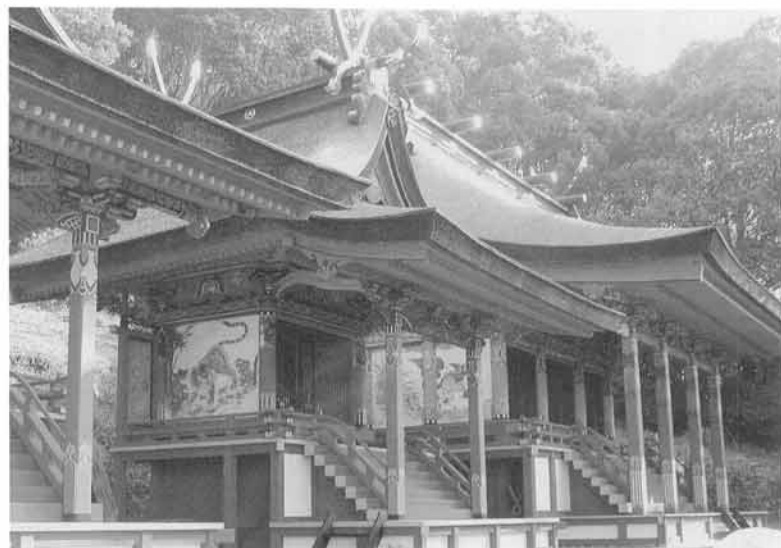
三船神社本殿ほか2棟 竣工全景
