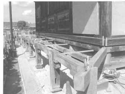
縁の修理状況
