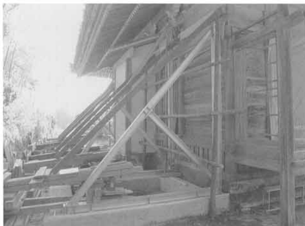
本堂建て起こしの状況
