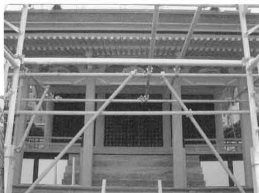
本殿塗装の状況
