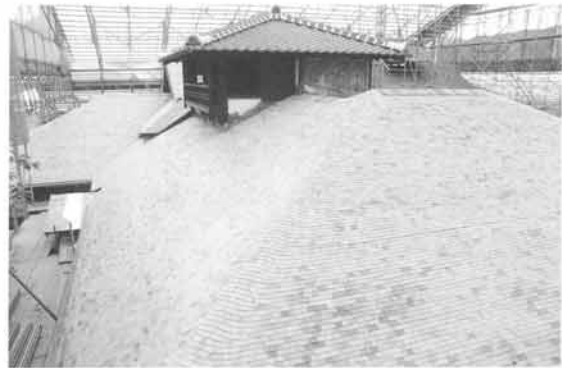
主屋土居葺きの完了状況
