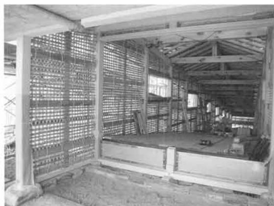
工事中の状況
