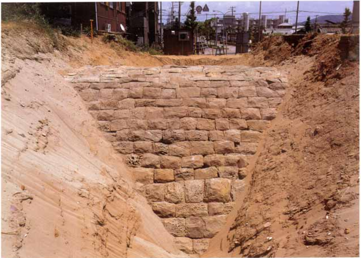
2. 水軒堤防の石積み 西側
