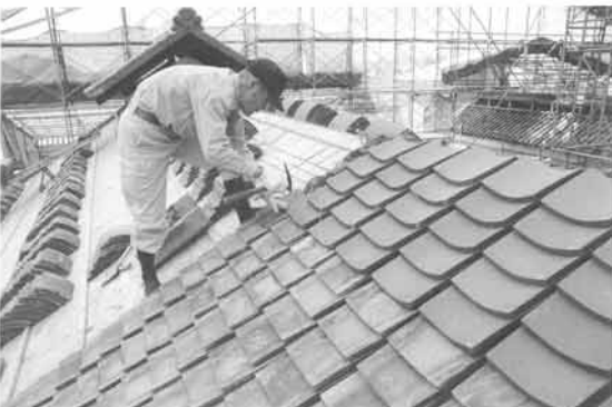
主屋土間台所部の本瓦葺き
