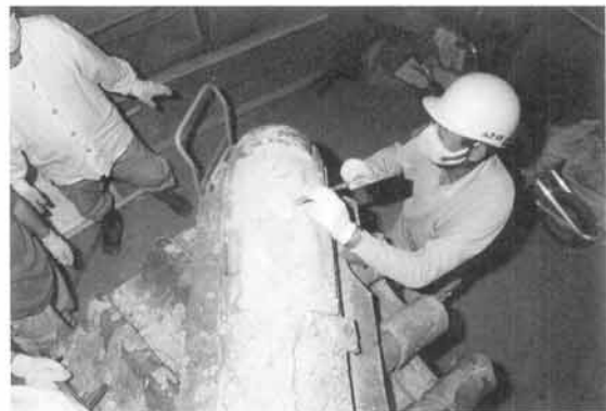
地元住民参加による屋根瓦解体
