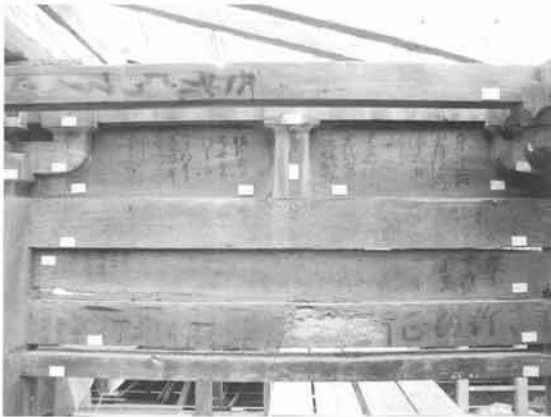
本堂外陣内部：墨書の状況
