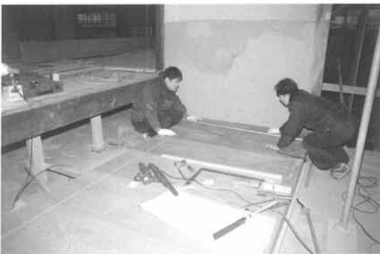
主屋式台玄関の組み上げ
