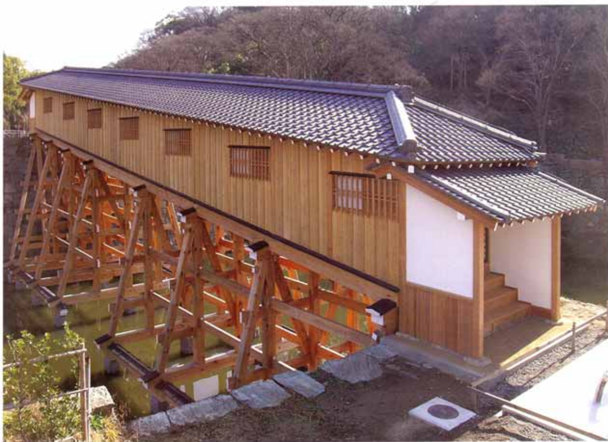
4. 和歌山城御橋廊下の竣工
