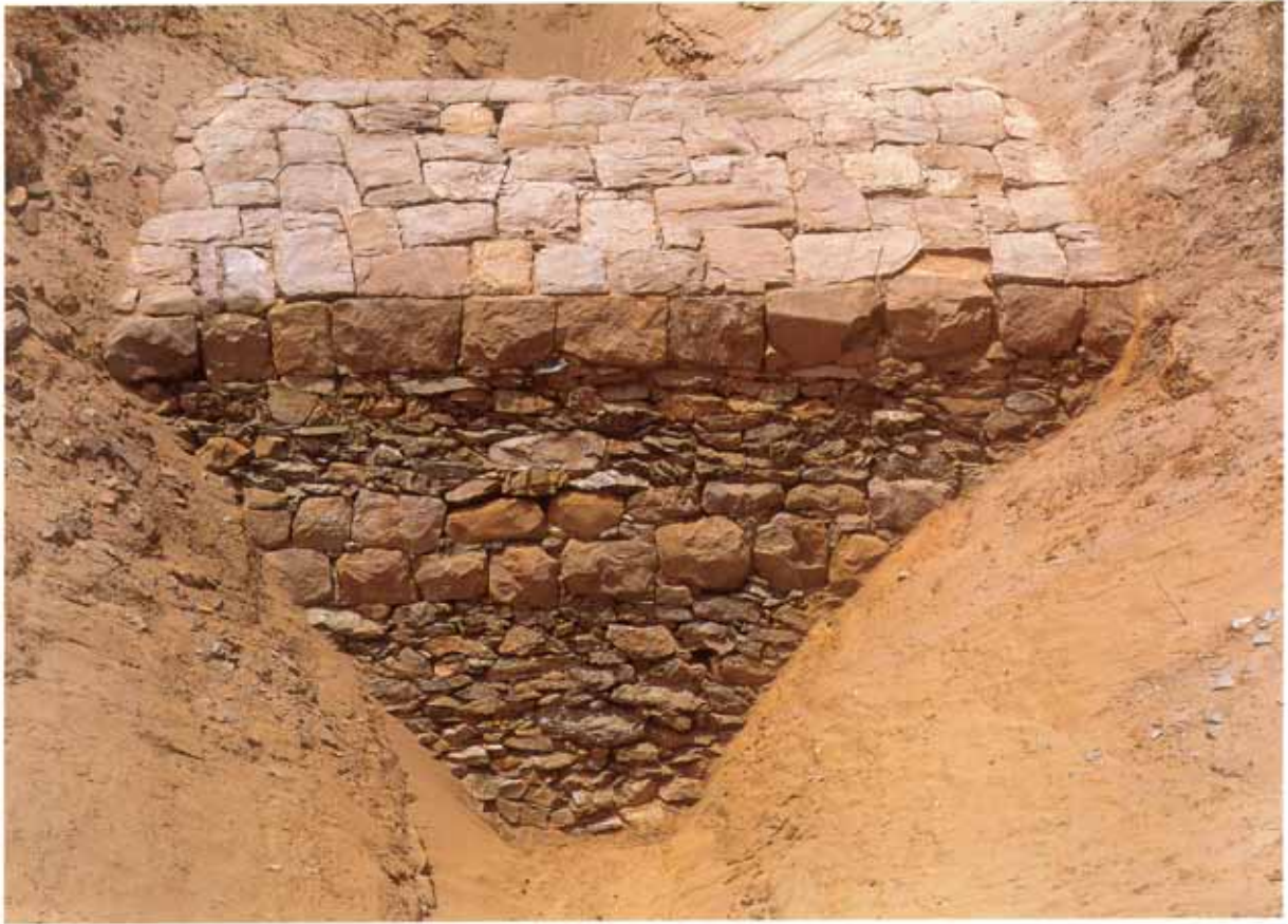
1. 水軒堤防の石積み 東側
