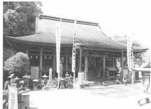
屋根の葺き替えが待たれる那智山青岸渡寺本堂
