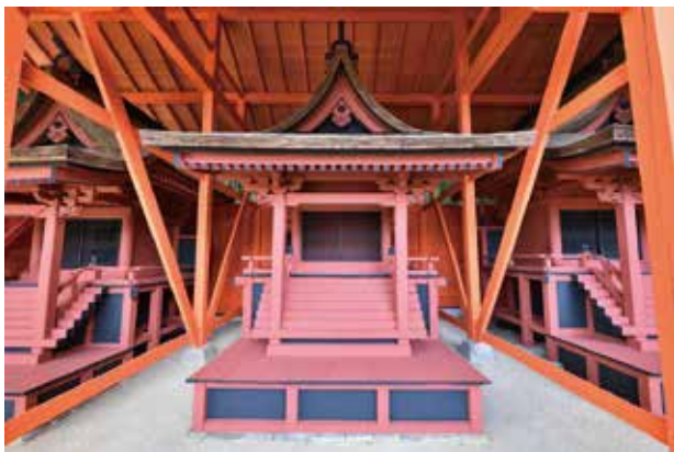
半解体修理が完了し、塗装や建具が復旧された三社権現
