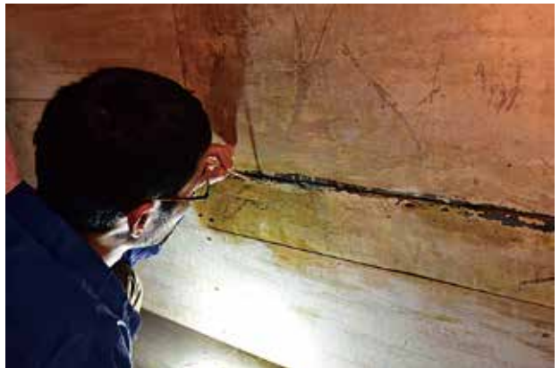
剥落止めの施工状況
