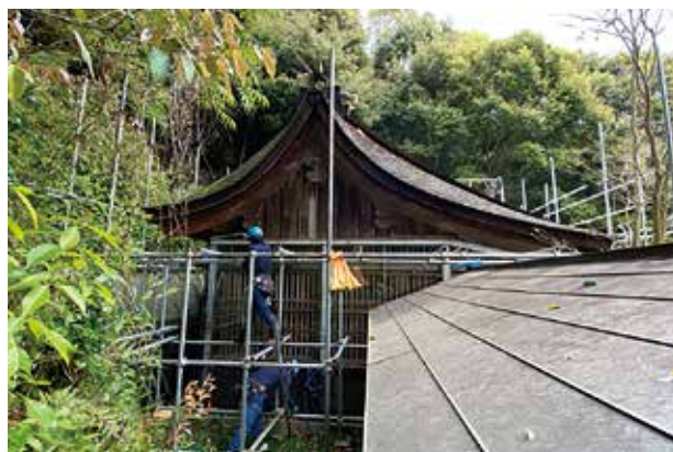
本殿の仮設組立状況
