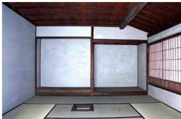
離れ内部の畳復旧状況
