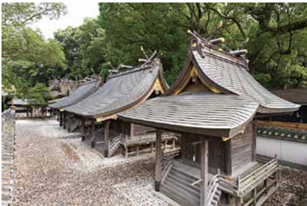
写真1 修理前の社殿6棟の全景（北西から見通す）
