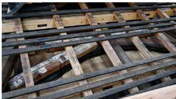
写真1 小屋組内に保管されていた部材
