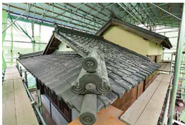
離れ・蔵竣工（南東隅から見る）
