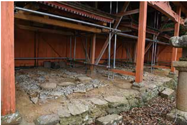
写真1 調査前の三社権現(北西から)
