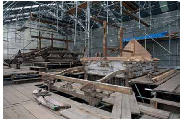
写真2 軒までの解体を行った本殿と上殿（手前）
