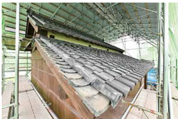
離れ・蔵竣工（北西隅から見る）
