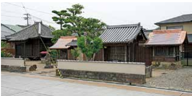
整備事業後の大福院を南から見る（右手前が鎮守堂）
