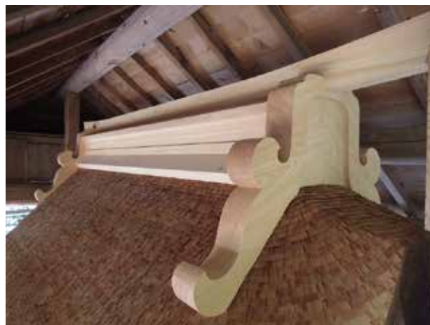
大棟の箱棟完成
