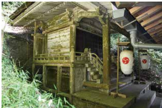
写真2 修理前本殿全景 (南西からみる)
