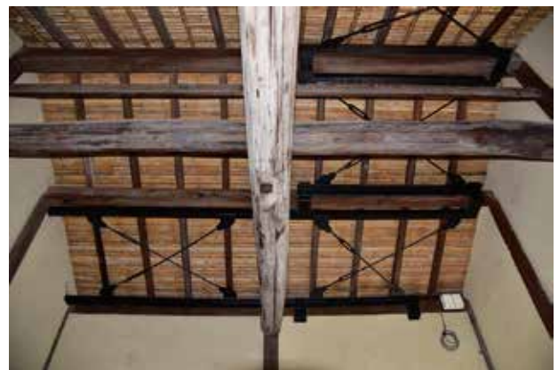
②野地に沿って取り付け鉄骨補強材
