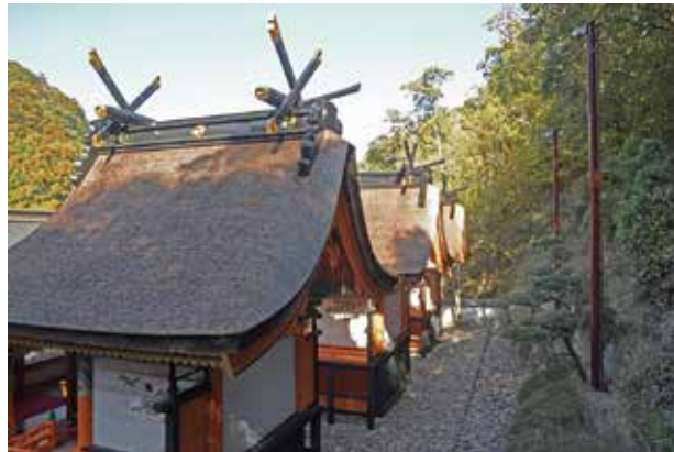
写真6 本殿後方での自火報設備設置状況（東から見る）
