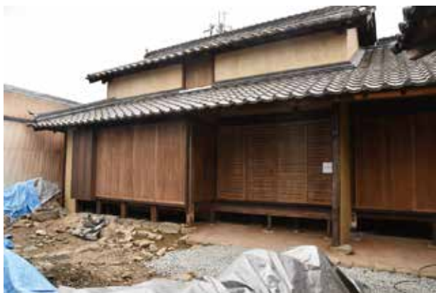
写真1 西棟施工完了状況
