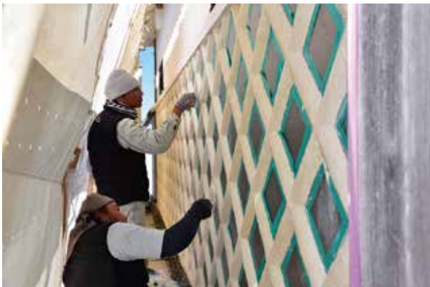
①漆喰塗りの施工状況
