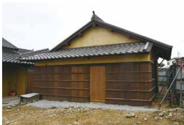
写真3 東棟施工完了状況
