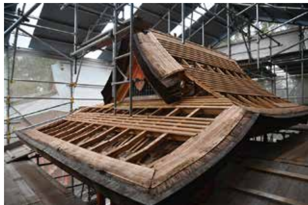
写真1 旧檜皮葺き解体状況
