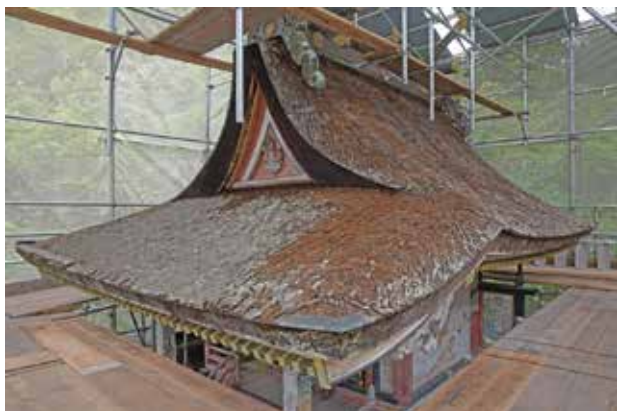
写真2 修理前の第三殿（素屋根内南東から屋根面を見る）
