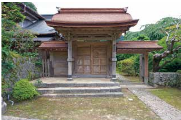
竣工後の表門（棧唐戸閉鎖時のすがたを南から見る）
