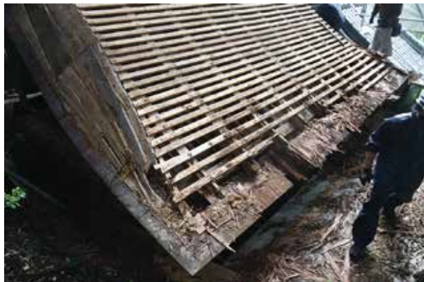
写真3 旧檜皮葺き解体状況
