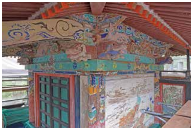
写真3 修理前の第三殿（軒下の塗装・彩色、金具解体時）
