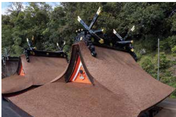
写真1 修理後の第一殿（手前）・第二殿（素屋根解体中）
