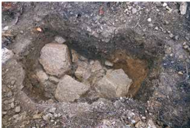
基礎工事東3区 第2遺構面石囲い状遺構（東から）
