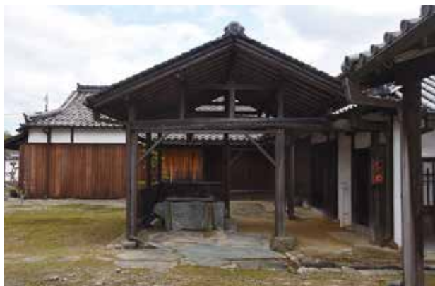
写真2 井戸屋形の補強状況(西面)
