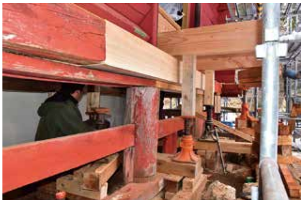
土台補足材の組み立て状況
