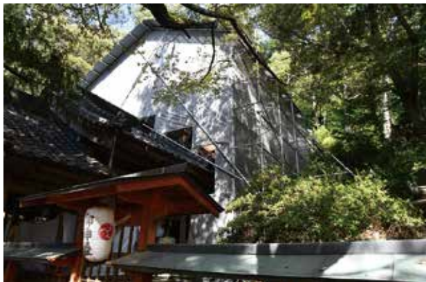
写真1 素屋根の組立状況
