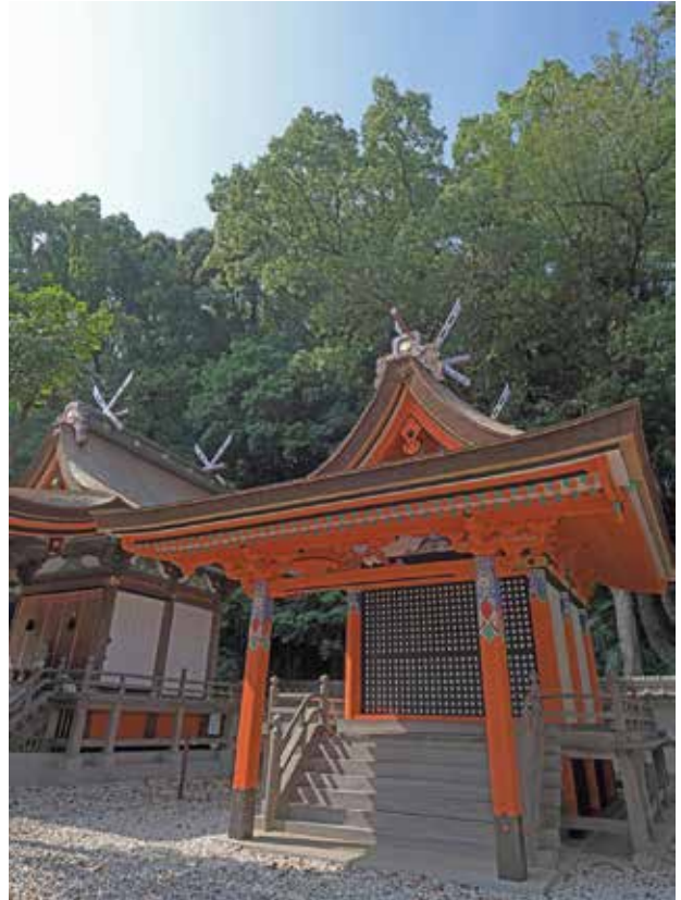
写真2 竣工した上殿を北側から見上げる
