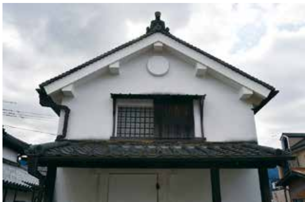
写真3 南倉の左官補修状況(北面破風まわり)
