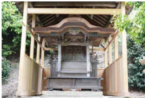
竣工した施無畏寺鎮守社
