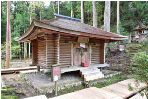
竣工正側面(北東面)
