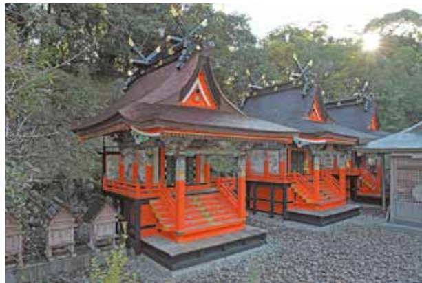
写真5 第三殿（手前）修理後の社殿全景（西から見る）
