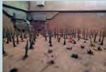
天井裏に設置されている和釘で作られた小動物避け
