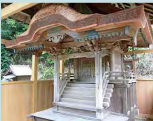
竣工した施無畏寺鎮守社
