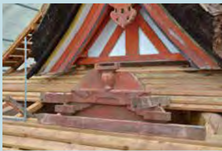
寶來山神社の本殿(平成期の修理中) →昭和46〜47年の修理では、正面の妻飾(ツマカザリ)を痕跡に基づいて慶長期再建時(1614年)の姿(奥)に復原し、江戸時代中頃に改変された部材(手前)は屋根内に保管されていました。
