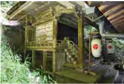
写真1 白岩丹生神社本殿全景 (修理前)
