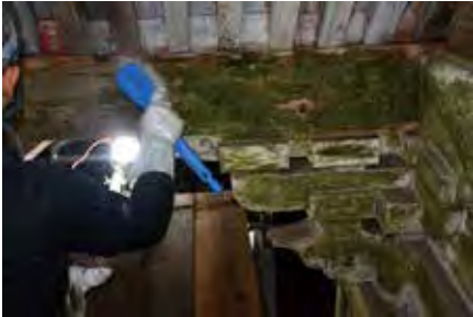
写真2 本殿の藻類清掃作業状況 (背面東側)
