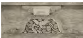
写真7 身舎頭貫木鼻（側面）の比較
