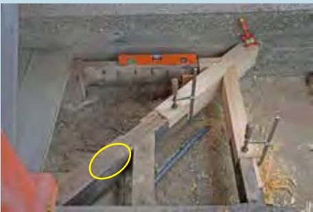
廣八幡宮の拝殿(縁まわり修理中) →縁を支える隅扱首(スミサス)という部材には「昭和二十九年修補」の焼き印が押されていました(写真の丸囲み箇所)。
