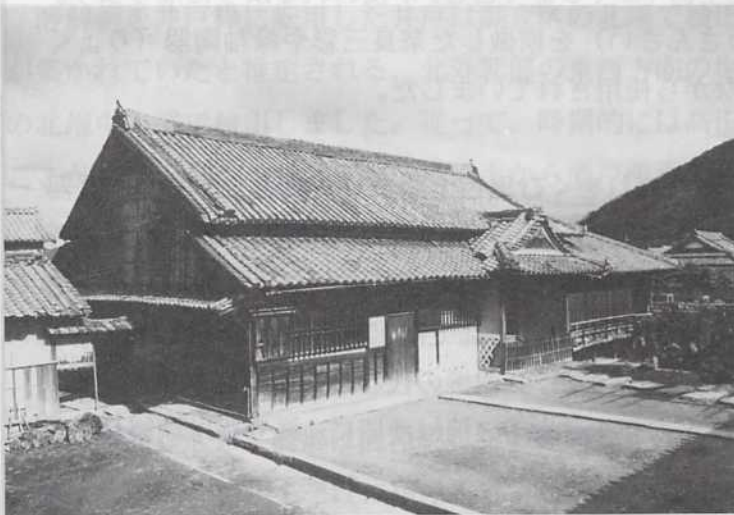
■ 主屋の修理前全景
