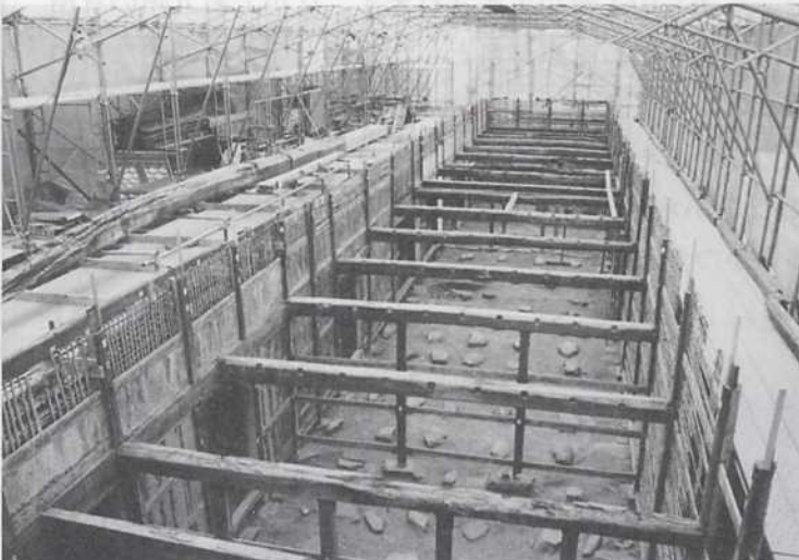
■ 長屋蔵の解体状況
