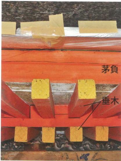
写真3 修理前の軒廻り塗装状況。垂木木口の金具は取り外した状態
