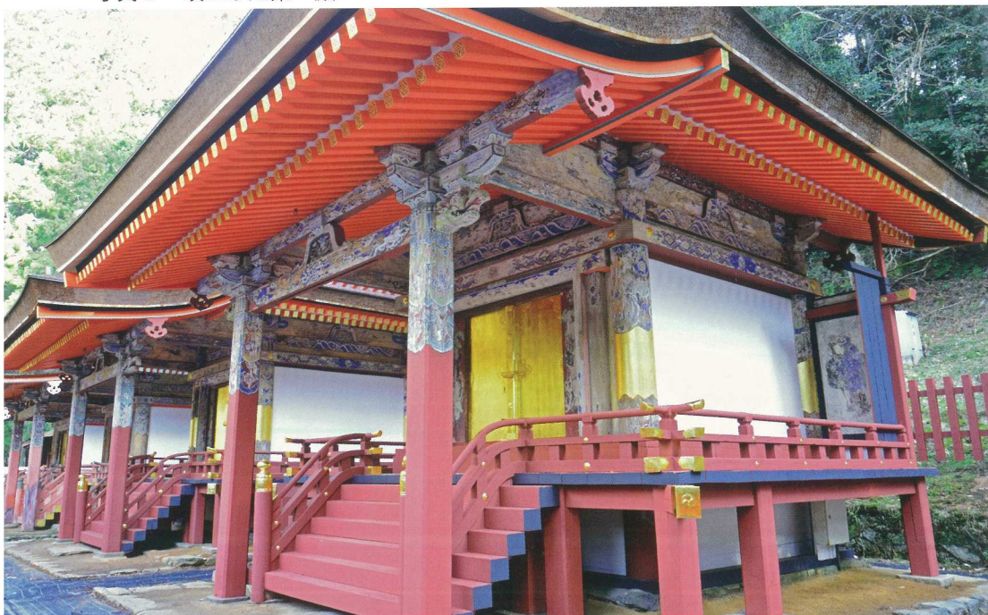
写真9 竣工した第一殿
