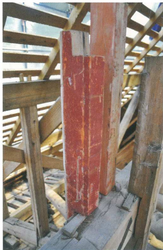
写真7 第二殿の小屋内。 2本の垂木が転用されている。
