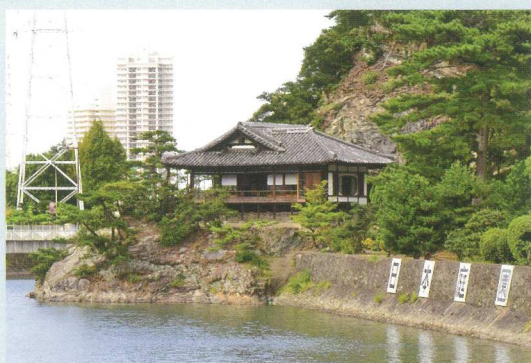
写真1 修理前の浜座敷を東より望む
