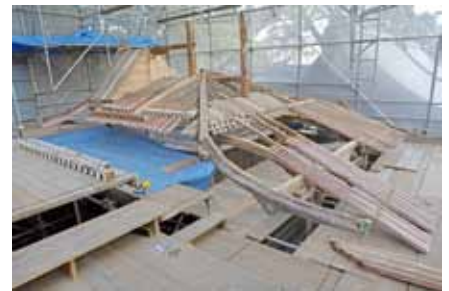
写9 軒まわり分解中の上殿
