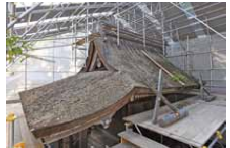
写7 千木と勝男木を降ろした本殿屋根
