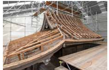
写8 檜皮と野地を解体した後の本殿
