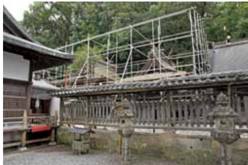
写6 瑞垣越しに見る本殿と上殿(素屋根建設中)
