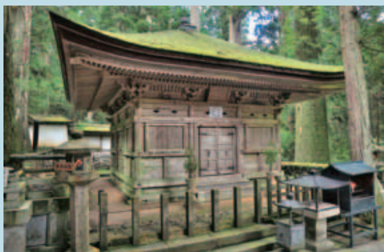
金剛峯寺奥院経蔵の修理前全景
