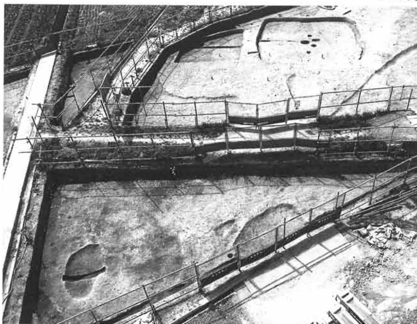
川辺2次D調査区 全景 (東から)
