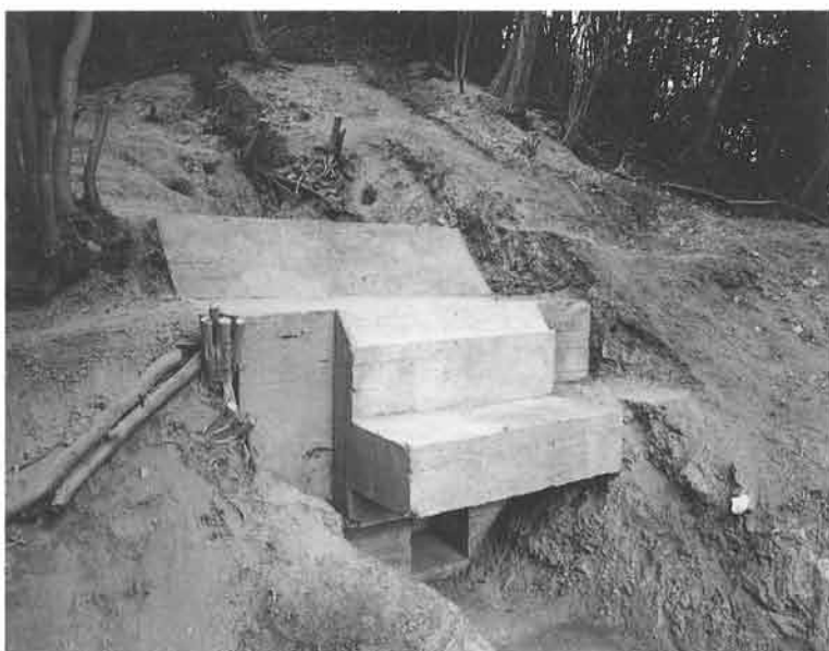
トーチカ(南東から)
