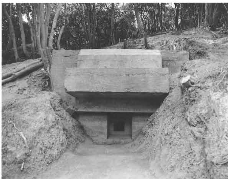
トーチカ(東南東から)
