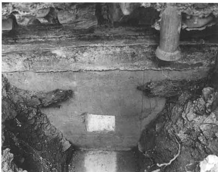
トーチカ内部
