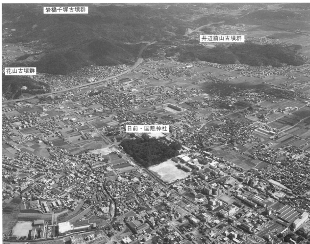
1 遺跡遠景（北西上空から）
