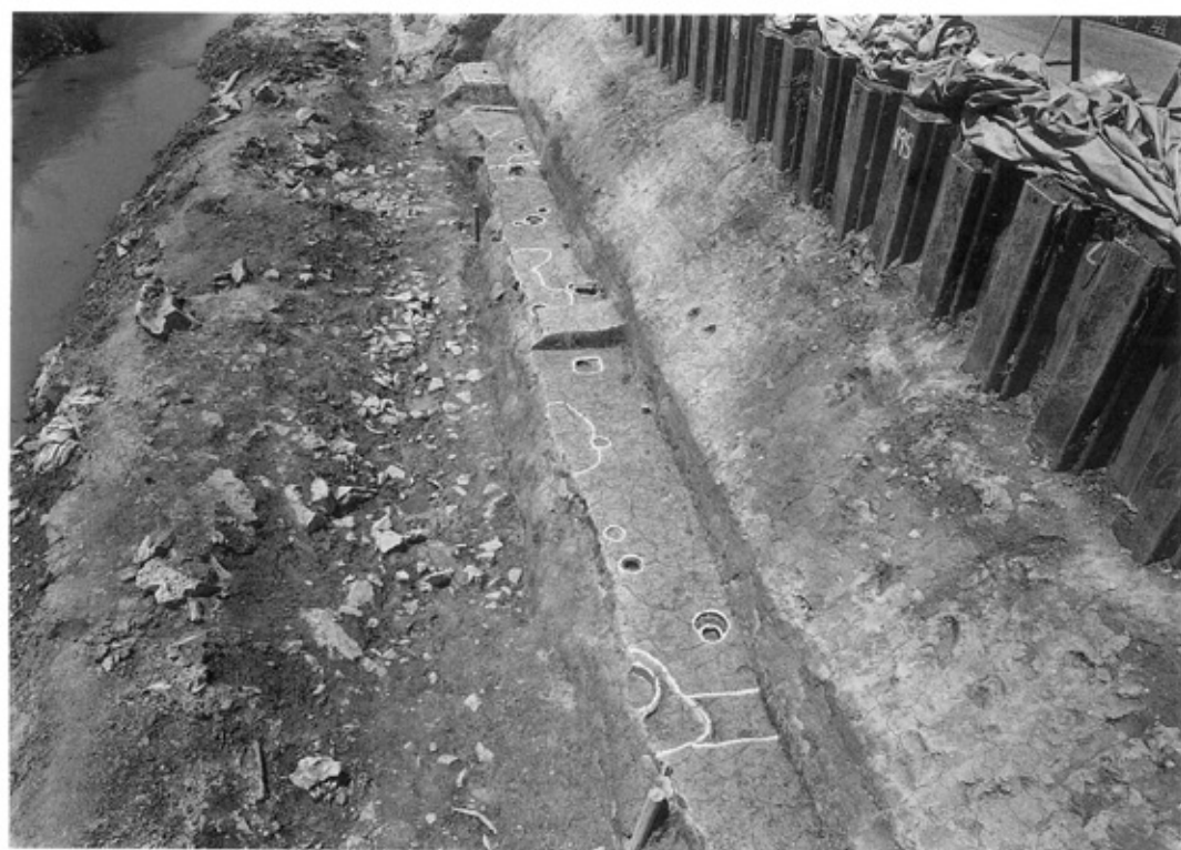
3 区 西半遺構全景（東から）
