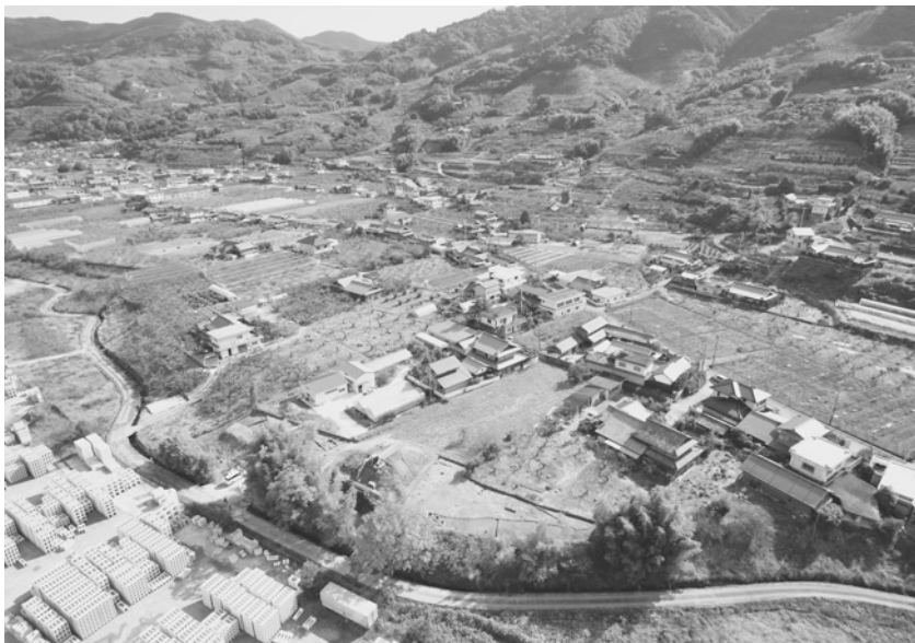
1. 調査地遠景 1 (北西上空から)
