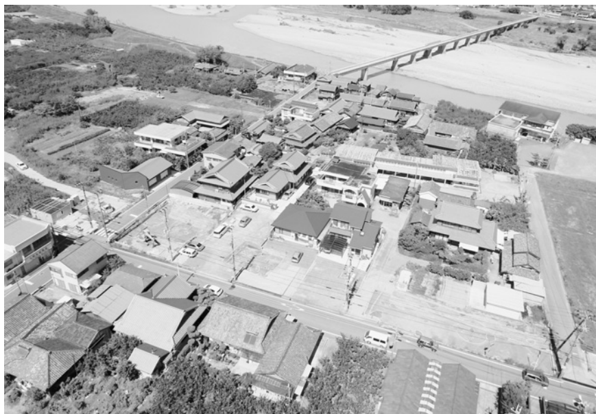
1. 3～9区調査地遠景(南東上空から)
