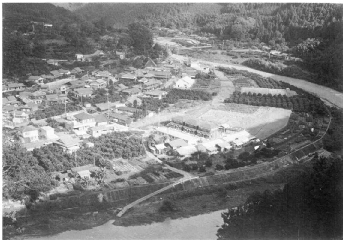
2 調査地遠景 北西から
