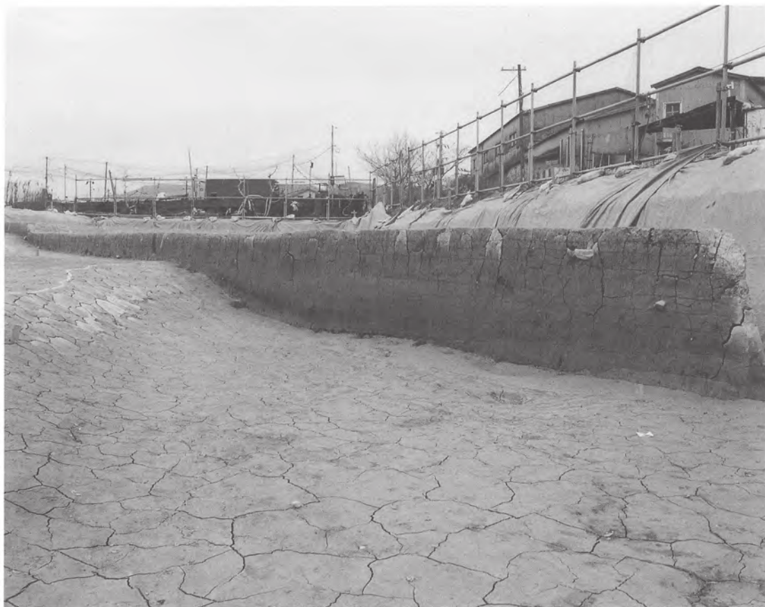
7・8区 セクション① (西から)
