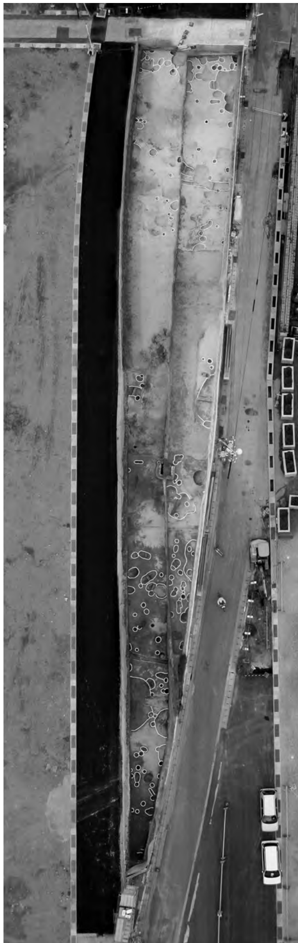
2. Ⅲ区 第2遺構面全景（上空から）
