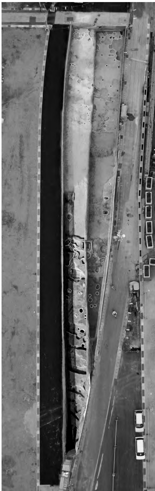
1. Ⅲ区 第1遺構面全景（上空から）
