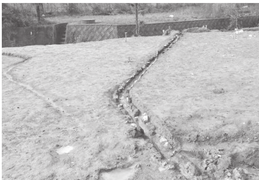
2. 2次3区1溝蓋石除去後 (北から)
