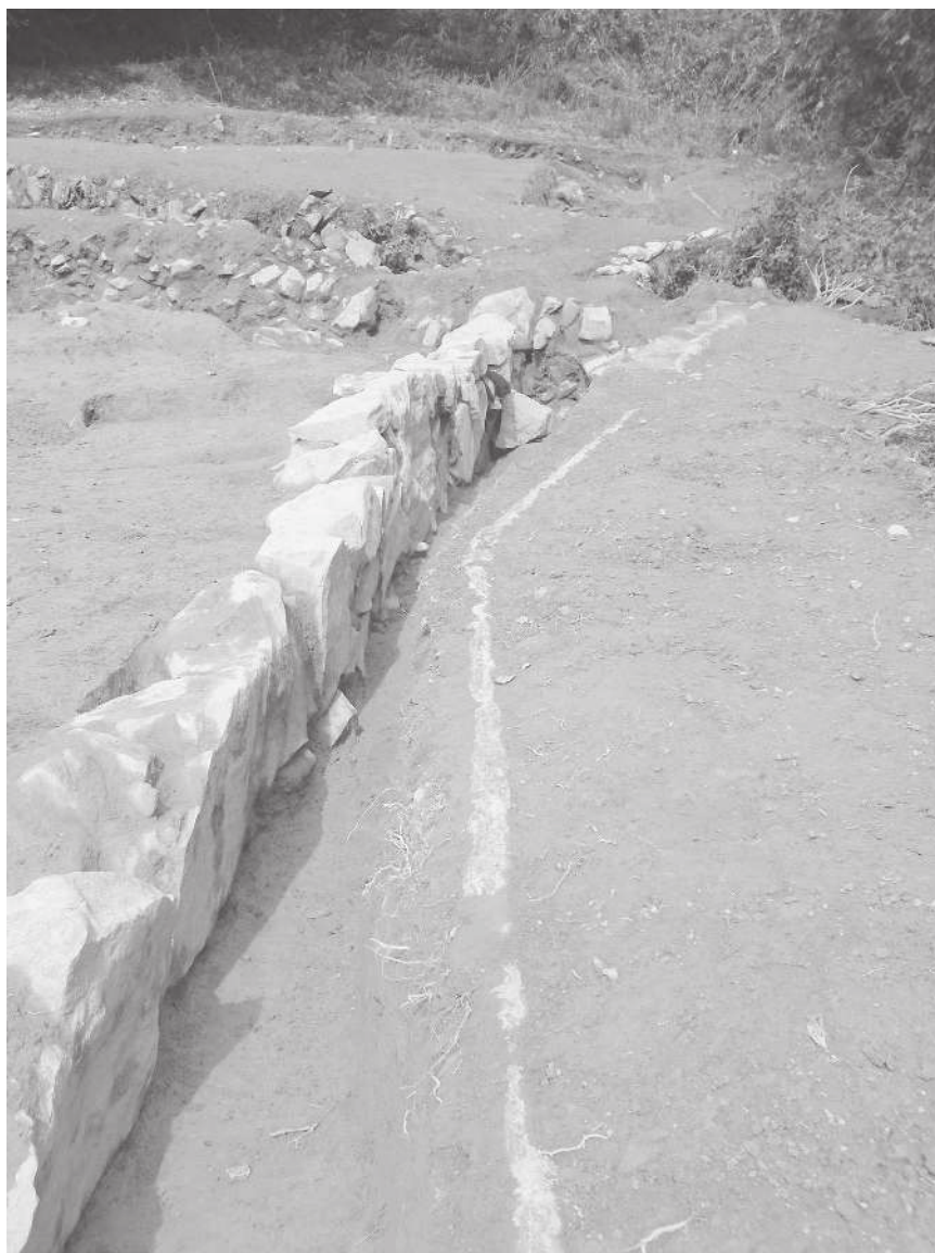
1. 1次2-1区331 石垣石積状況（南東から）
