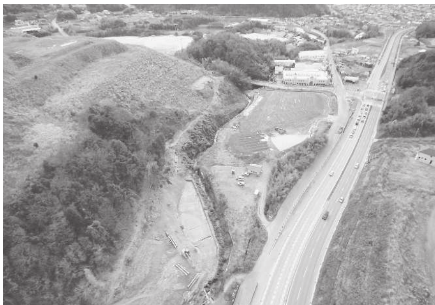
1. 2次調査地遠景（北西上空から）
