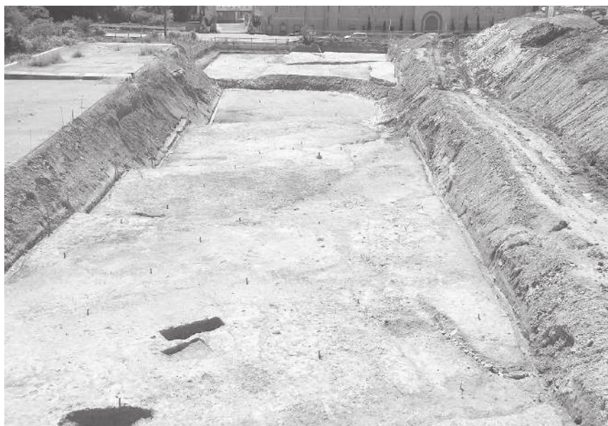
1. 1次1-1区全景(北から)
