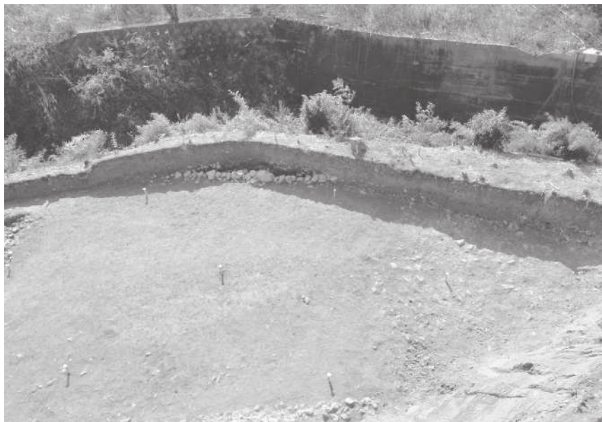
1. 2次3区3石垣（北東から）
