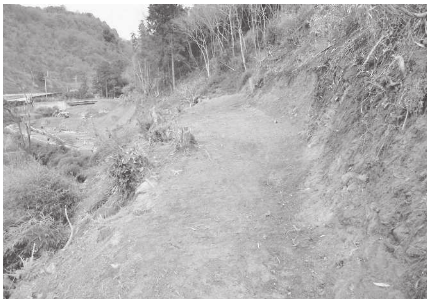
2. 2次4-1区中央部掘削完了状況 （南から）
