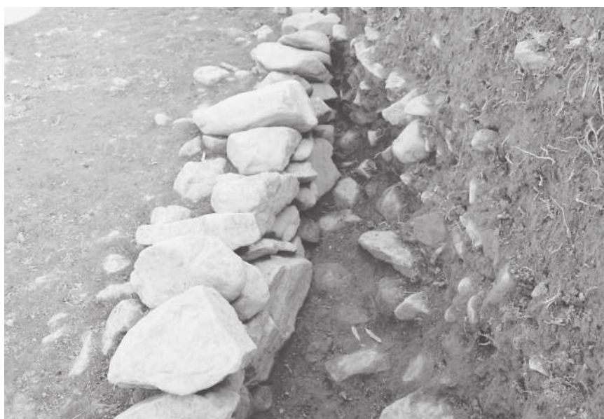
2. 2次3区3石垣（南東から）
