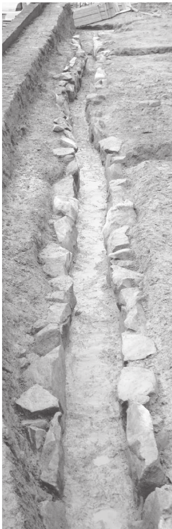
2. 1次2-2区317暗渠蓋石除去後 (北東から)
