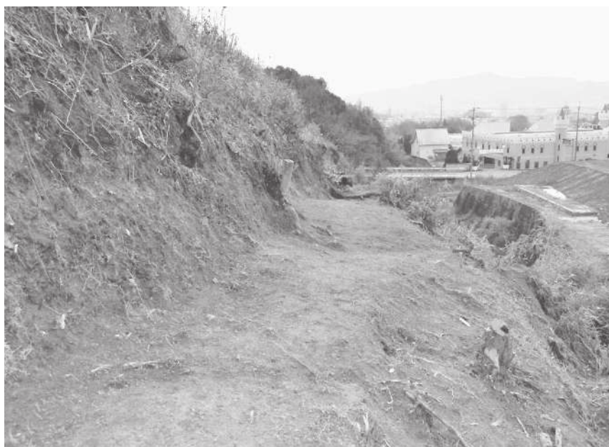
3. 2次4-1区南側掘削完了状況（北から）
