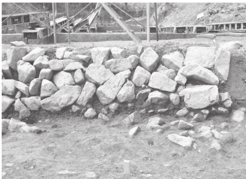
3. 2次3区1石垣石積状況 （南東から）
