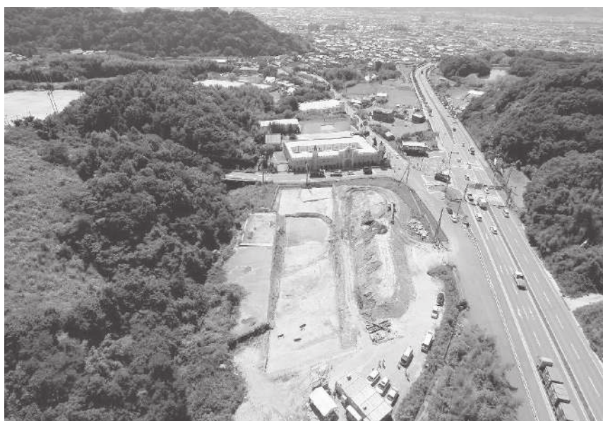
2. 1次1区調査地遠景(南西から)
