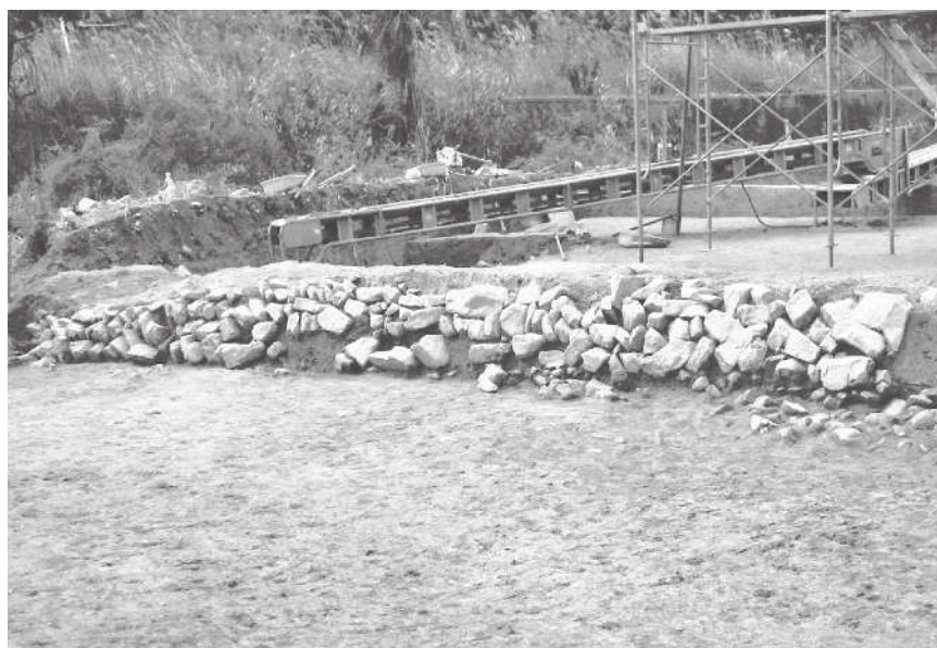
2. 2次3区1石垣（南東から）
