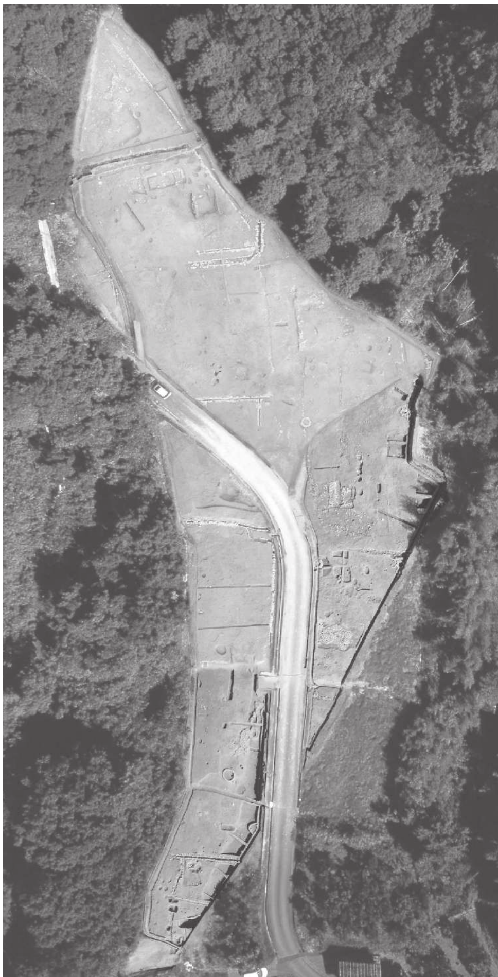
1次2-1区・2-2区合成写真(上空から)
