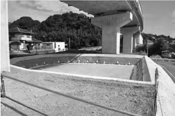
写真 3 移設復元設置坑
