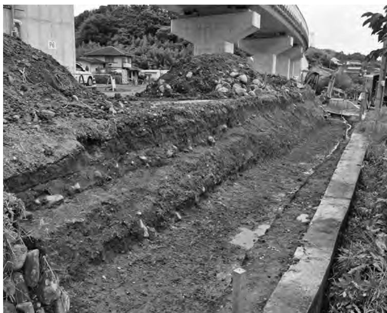
11-1 区 11001 検出状況 (西から)
