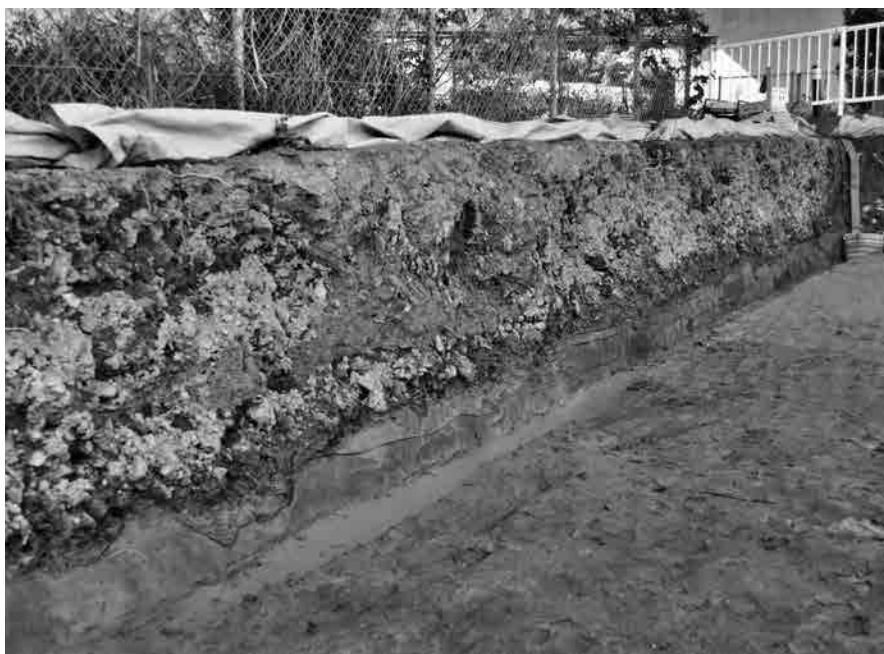
2 3区 調査区西壁中央～北端断面土層(南東から)
