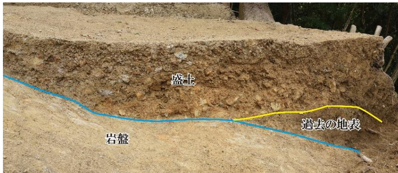
写真1 平坦部の岩盤落ち込みと盛土の様子（北から）
