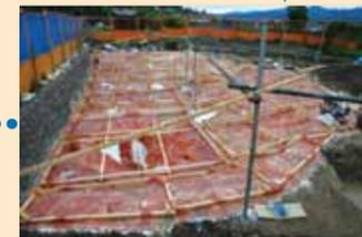
④角材で型枠を作成し補強
