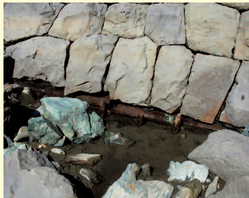
石堤基底部胴木（南西から）
