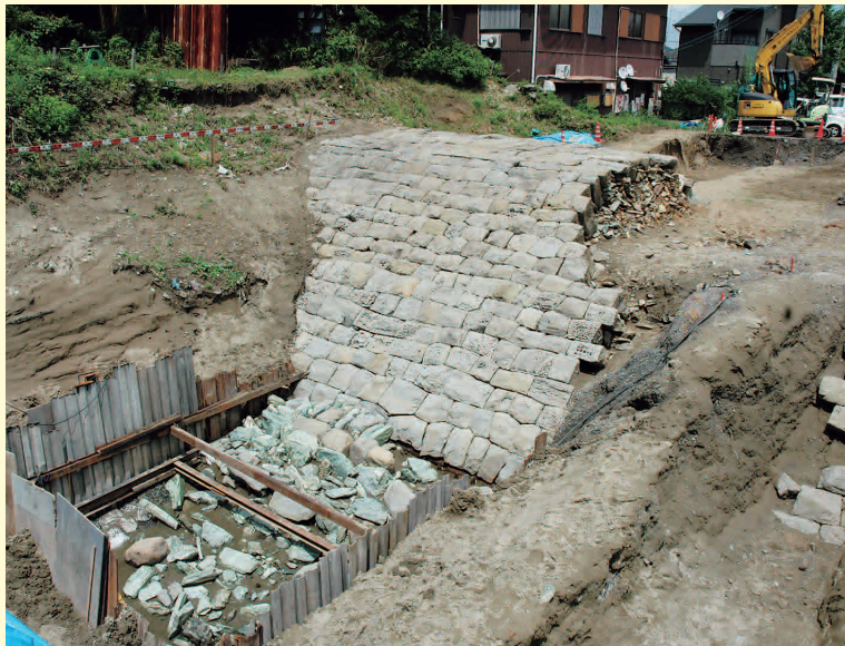
石堤と海側に設置された石敷（南西から）
