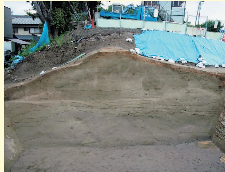
土堤断面（北から）
