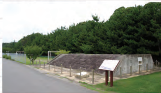
移築石堤と水軒堤防
