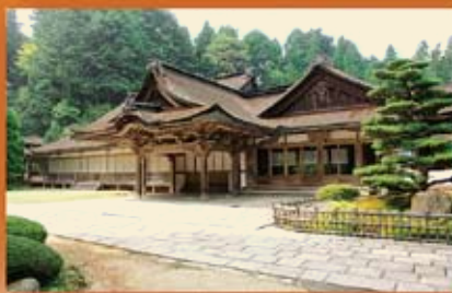
上段左: 真然堂出土緑釉四足壺 上段中: 金剛三昧院客殿出土賢瓶 上段右: 大門基壇内の発掘状況 下段左: 大門出土輪轆 下段右: 金剛三昧院客殿及び台所
