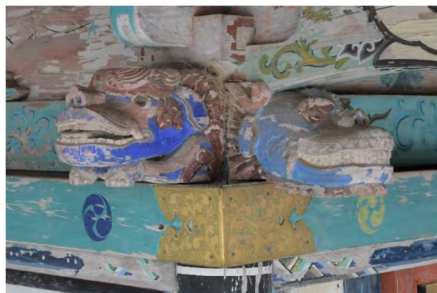
写真5 彩色面の劣化状況(第二殿、木肌が見えた箇所も存在。頭貫端部の彫刻は、左が獅子、右が龍)
