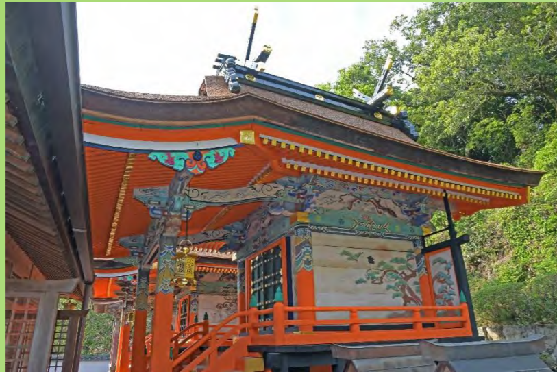
須賀神社、修理後の第一殿
