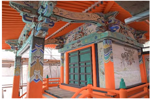
写真7 修理後の第二殿(彩色部補彩、単色塗り後)
