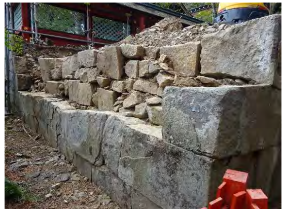
写真6 石垣3段目解体後 正面（南東から）
