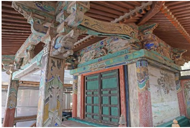
写真6 修理中の第二殿(彩色部の剥落止め施工後)
