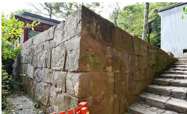
写真2 石垣の修理完成状況
