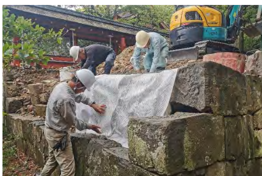
写真3 石垣の修理状況
