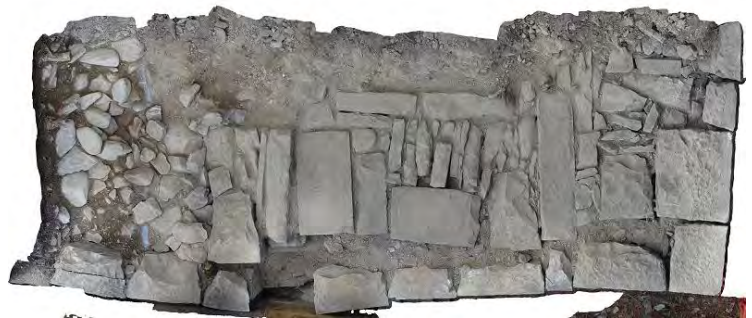
写真7 石垣1段目解体後 上面
