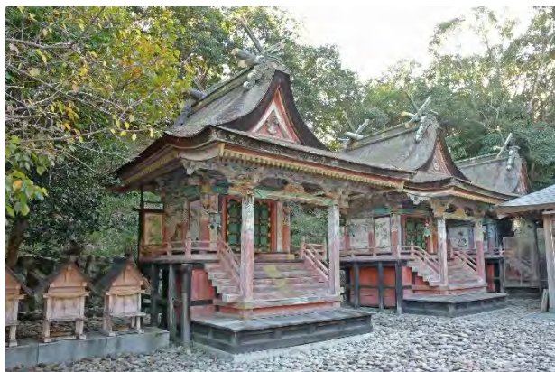
写真2 修理前の本殿(南西から、手前が第三殿)
