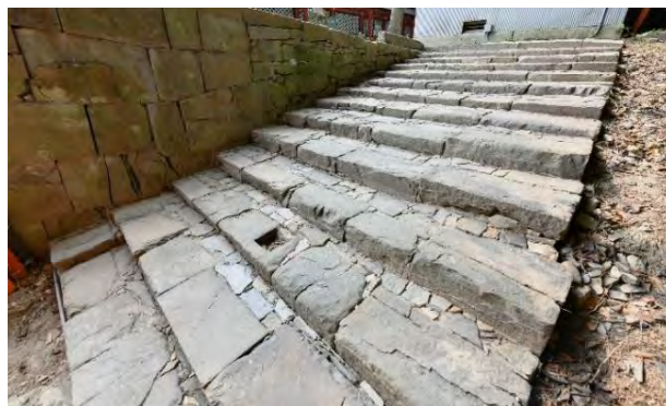
写真5 石階段の修理完成状況
